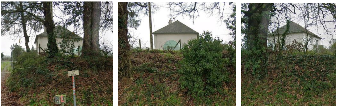
Figure 15 : Façade Nord du bâtiment R3
