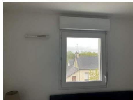
Fenêtre F1 - chambre
