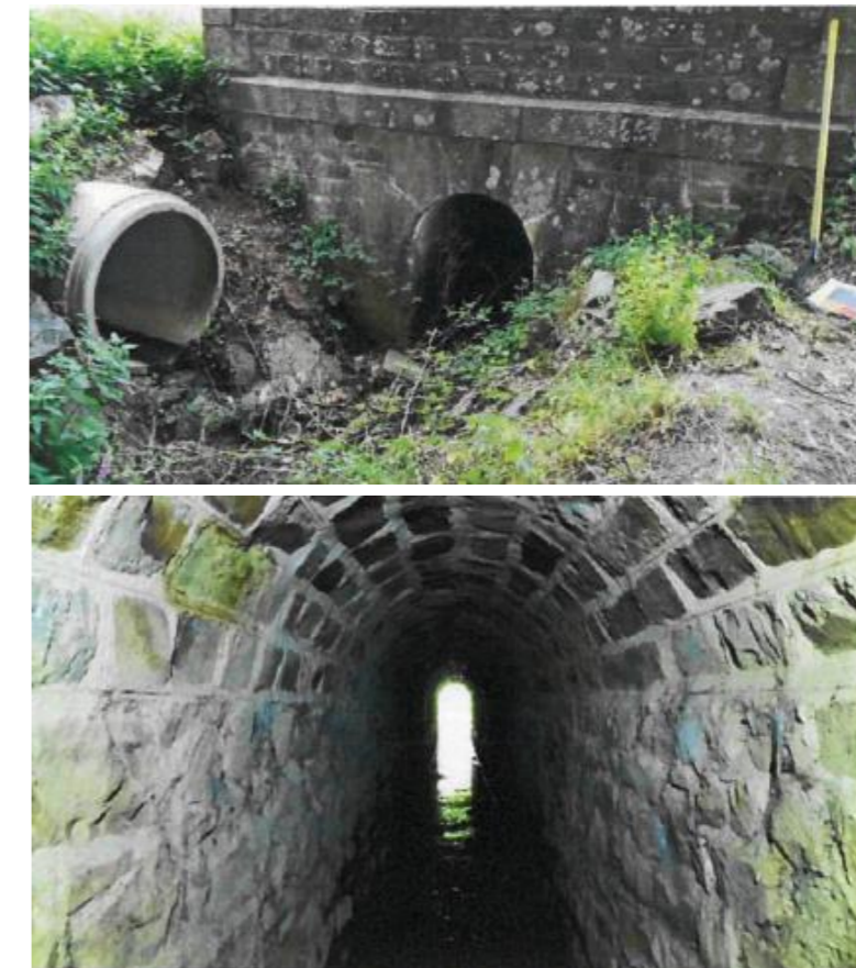
FIGURE 23 : L'AQUEDUC MAÇONNE EN PLACE SOUS LES VOIES SNCF
