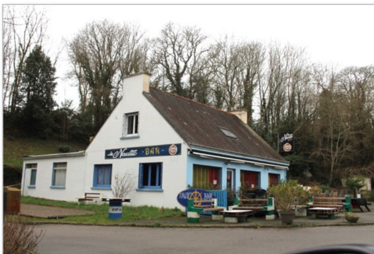
Enseignes murales. Celle à l'opposé du bâtiment dépasse du mur (illégal) - Site inscrit - Moëlan-sur-Mer
