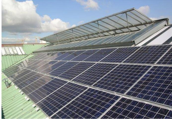
**Panneaux photovoltaïques en surimposition sur toiture existante en bacs acier - puissance de 7,35 kW (Lyon, 2006)**
