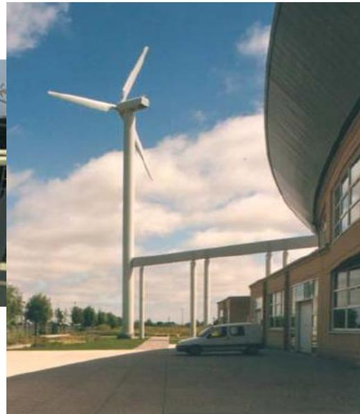
Source : wikipedi **Eolienne à axe horizontal du lycée Léonard de Vinci à Calais hauteur 35 m, puissance 132 kW (source : ARENE)**
