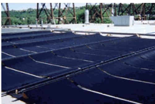
Les capteurs dits « moquette » non vitrés, sont souples mais ont un mauvais rendement. Ils peuvent par exemple servir au chauffage de l'eau d'une piscine, mais pas à la production d'ECS.
