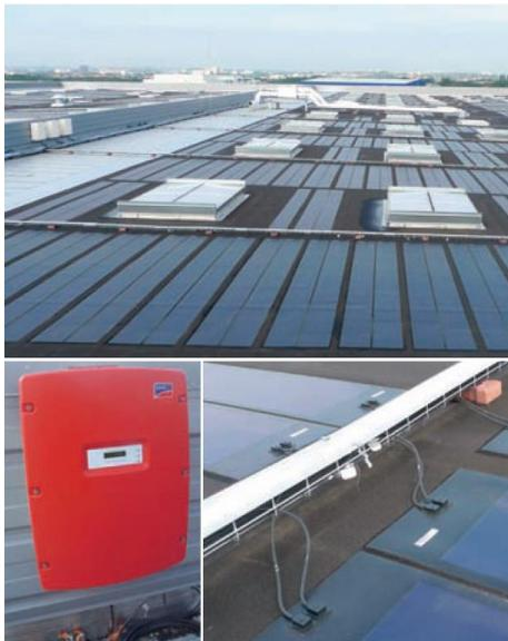
**Membrane photovoltaïque amorphe sur toiture des entrepôts Sisley à Saint-Ouen-l'Aumône (95) - surface de 35000 m<sup>2</sup>, puissance estimée à 848 kWc (source : cahiers techniques du bâtiment n°305 – avril 2011)**
