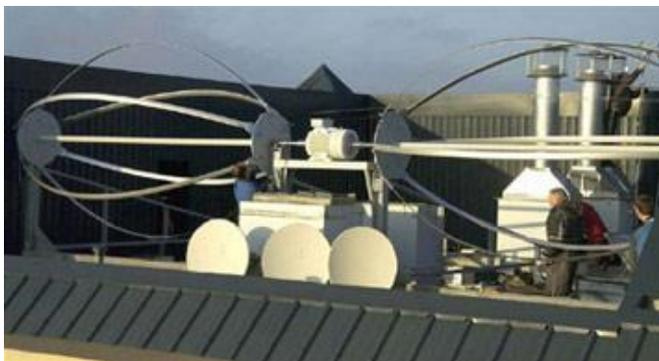
**Eolienne de type Darrieus à axe horizontal en toiture à Equihen en France (puissance : 6 kW)**
