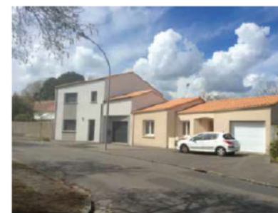
Logements équipés de garages privés à la Boissière
