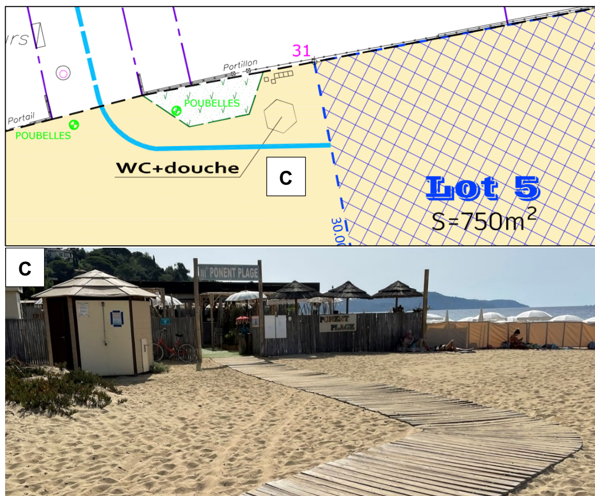
Sanitaires de la plage du Débarquement : A) bloc situé à l'extrémité ouest ; B) WC du bâtiment abritant le poste de secours ; C) bloc situé à l'est, près du lot n°5.
