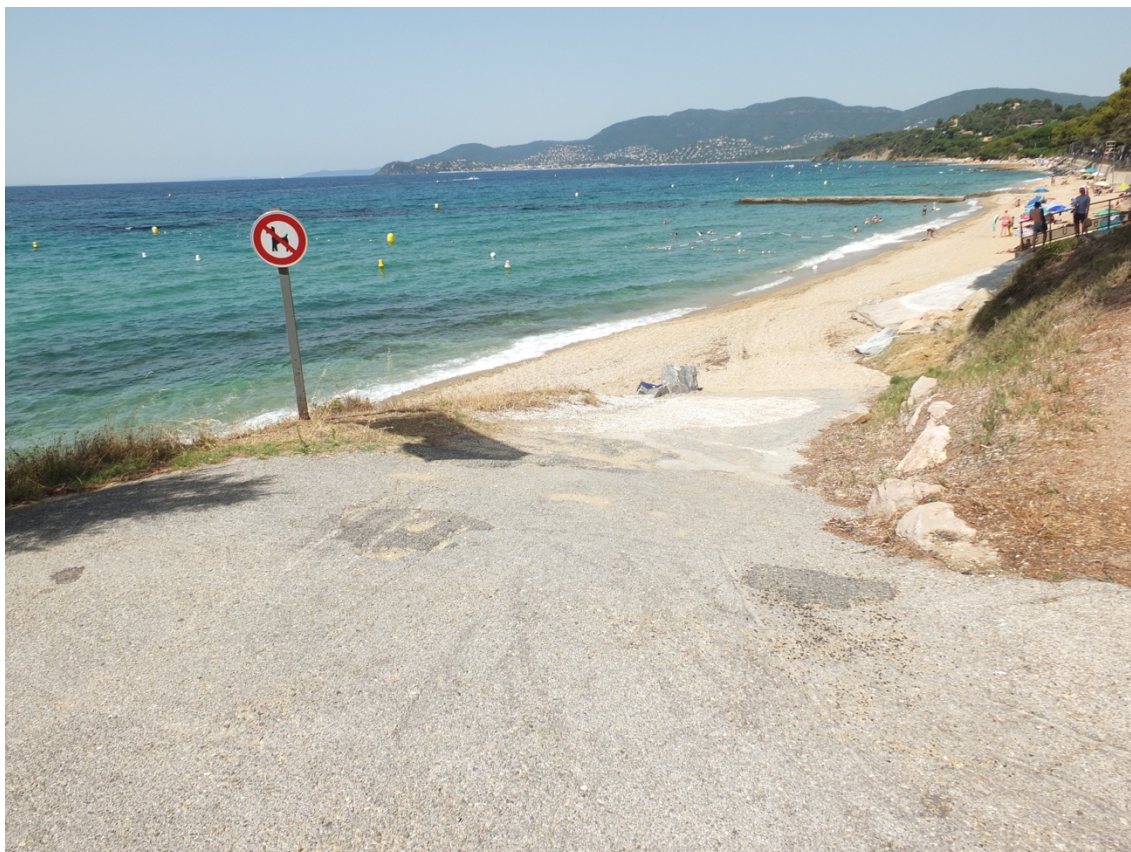
Photo de la rampe d'accès « centrale », offrant une pente de 17 %
