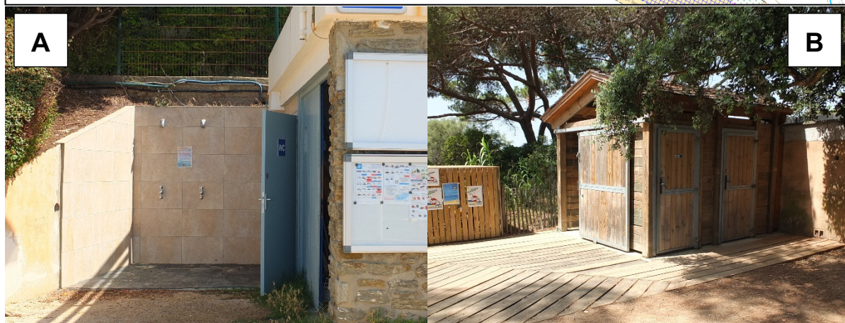
Sanitaires de la plage de Gigaro : A) dans le poste de secours de Gigaro ; B) site du Conservatoire du Littoral.
