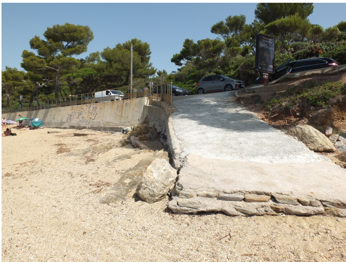
Photo de la rampe d'accès « ouest », offrant une pente de 26 %
