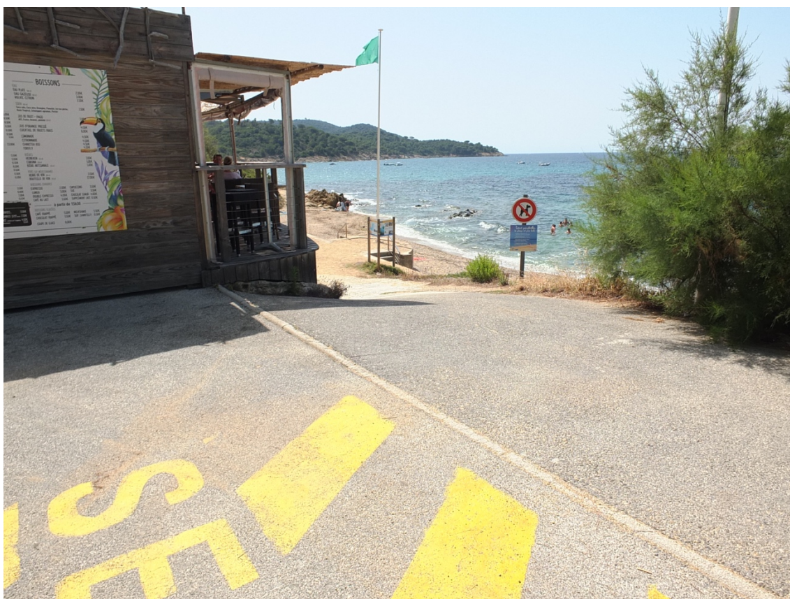
Photo de la rampe d'accès « est », offrant une pente de 18 %
