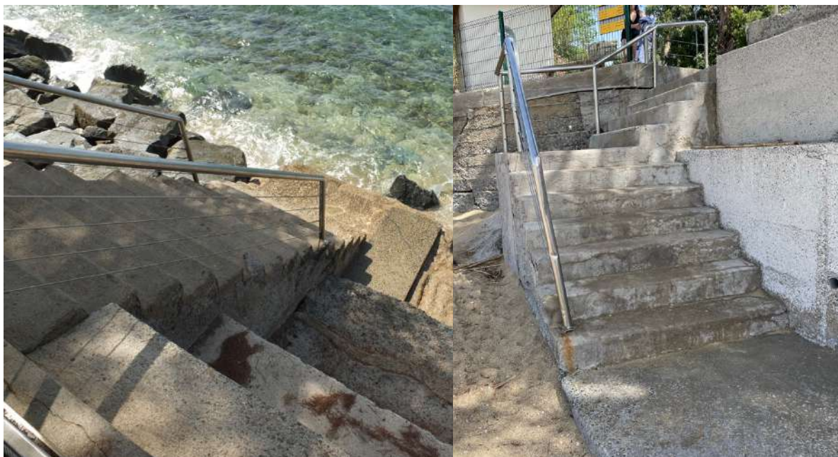
Photographies des 2 escaliers en partie est de la concession.
