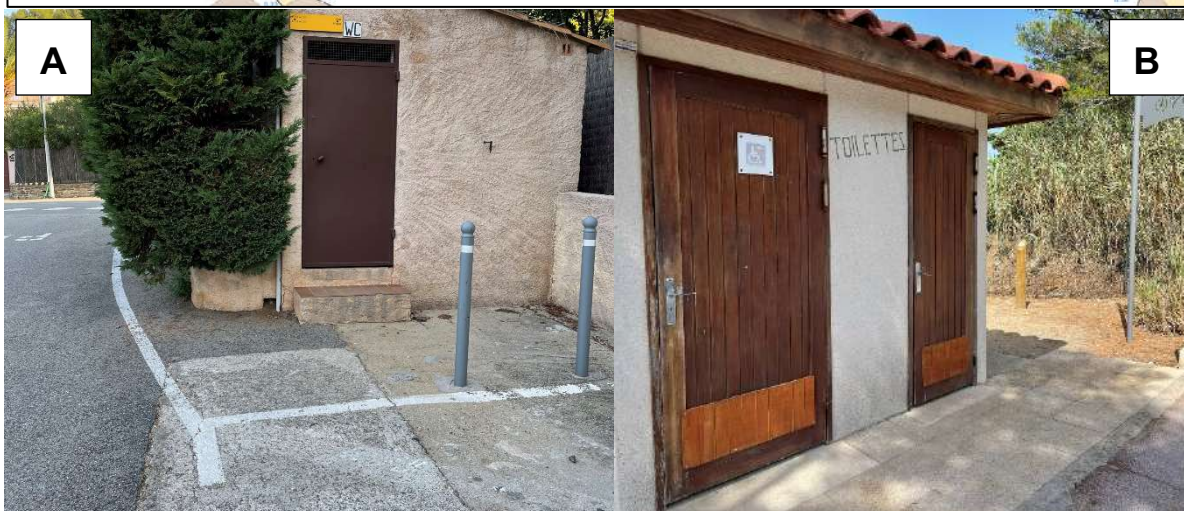
Sanitaires de la plage d'Héraclée : A) bloc à l'entrée de l'impasse d'Héraclée ; B) WC du boulevard de Gigaro
