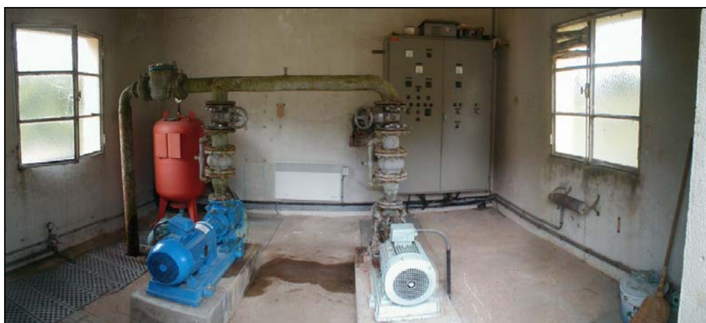
Etat intérieur de la station de pompage
