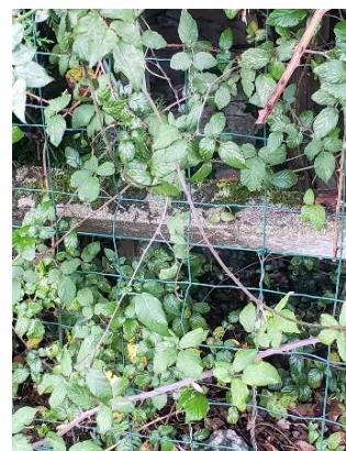
Photographie de l'ouvrage
