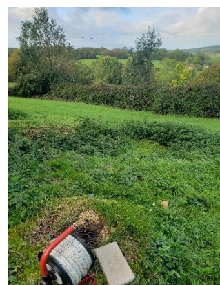
Photographie de l'ouvrage
