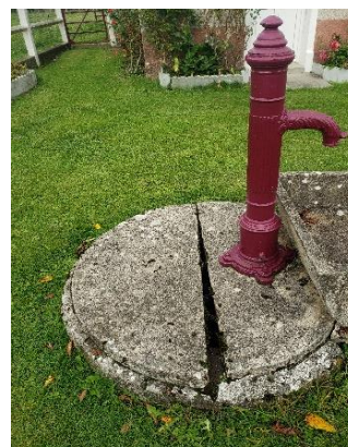
Photographie de l'ouvrage
