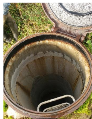
Photographie de l'ouvrage
