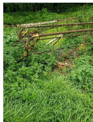
Photographie de l'ouvrage
