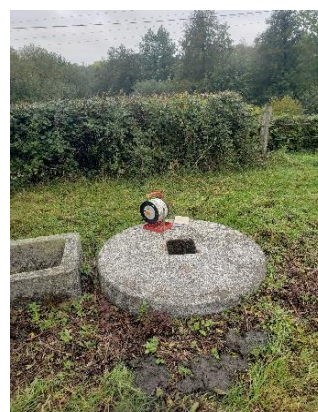
Photographie de l'ouvrage
