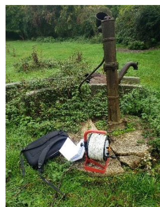
Photographie de l'ouvrage
