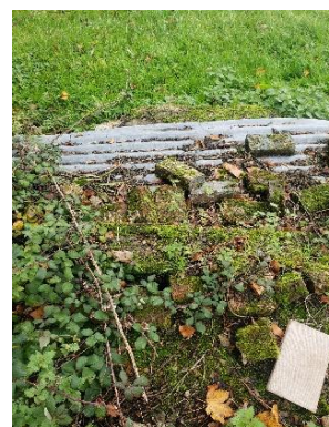
Photographie de l'ouvrage
