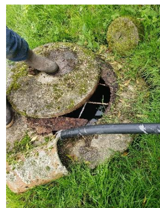
Photographie de l'ouvrage
