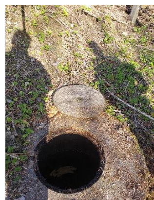
Photographie de l'ouvrage
