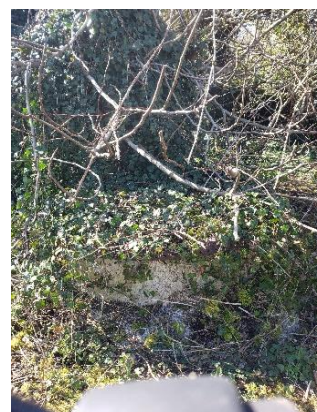
Photographie de l'ouvrage
