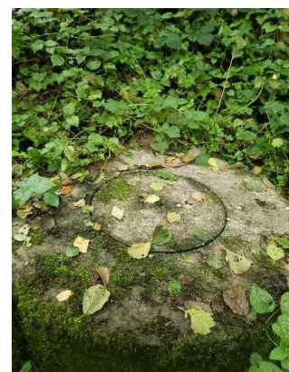
Photographie de l'ouvrage
