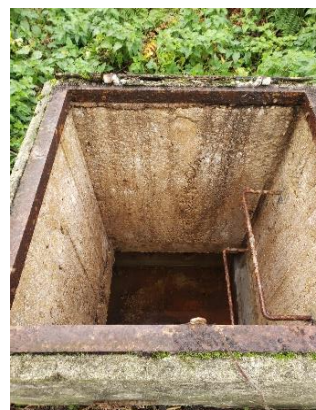
Photographie de l'ouvrage
