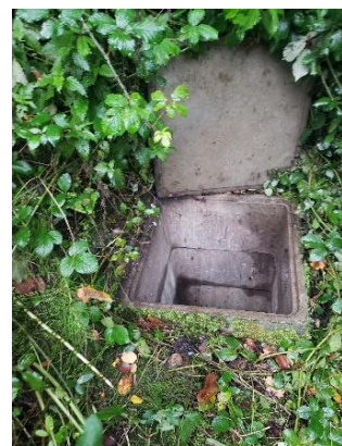
Photographie de l'ouvrage
