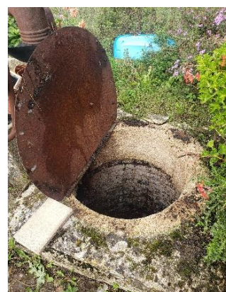
Photographie de l'ouvrage
