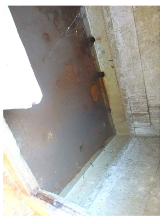
Ouvrage C1 "Chambre captante"
