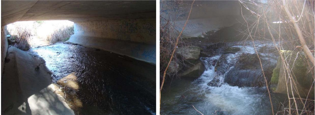
*Radier et seuil de stabilisation en bloc au niveau du pont de la RD522*
