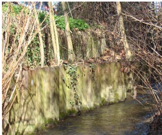
*Palplanches en rive gauche à remplacer par un mur de gabion en rive gauche*
