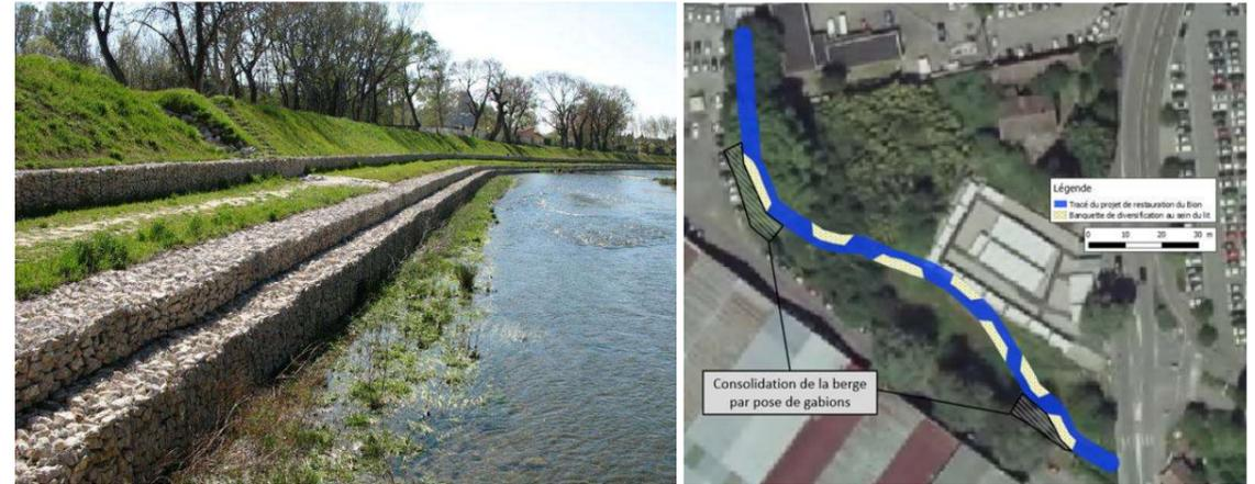
Le rapport de 2012 de la société CIDEE évoquait les fortes contraintes au niveau du fond du lit du Bion (vitesses maximales variant entre 3 et 4 m/s) d'après les modélisations hydrauliques.
