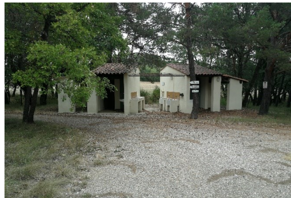
Repérage des bâtiments dédiés aux sanitaires
