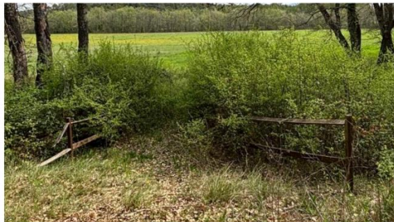
Petite passerelle en bois sur le ravin d'Enriou
