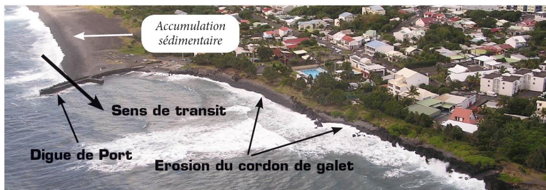
Figure 20 - Exemple de digue bloquant le transit sédimentaire à Saint-Benoît (De La Torre et al, 2012)
