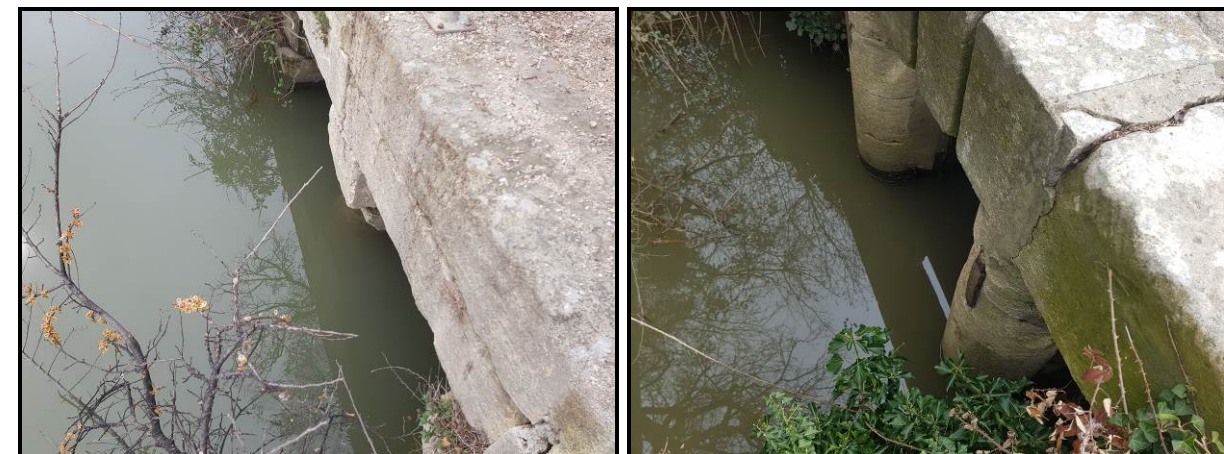
Exemples de bâtis présent sur site
