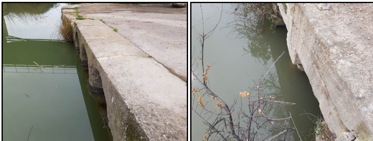
Vue de buses enterrées et bâtis à proximité du centre-ville de Saint Gilles
