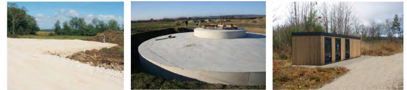
Figure 6: Aménagement des accès et des plateformes (à gauche), une fondation (au centre), et un poste de livraison (à droite)
