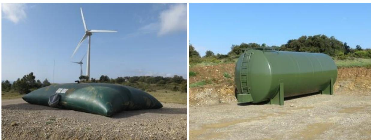
Photo 5 : Citerne souple de 30 m<sup>3</sup> (à gauche) et citerne rigide (à droite) – (parc éolien de Conilhac-Corbières, 11)
