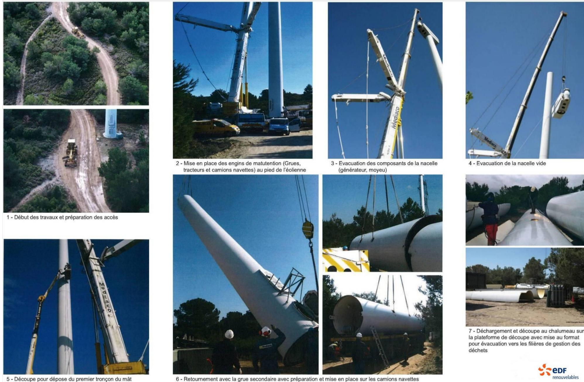
Figure 18 : Etapes du chantier de démantèlement du parc éolien de Sallèles-Limousis (11- Aude)
