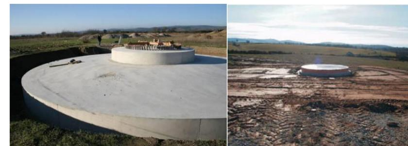
Photo 9 : Massif béton terminé (à gauche), état final après remblaiement (à droite)
