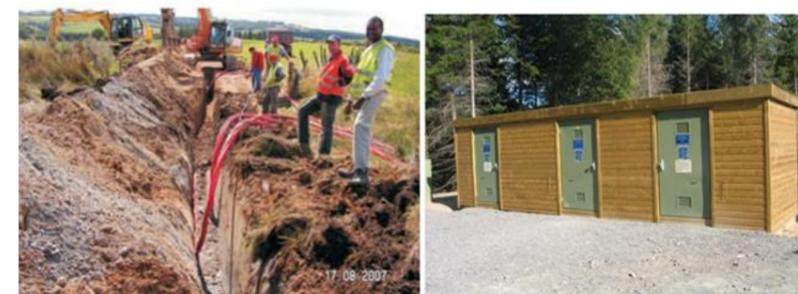
Photo 12 : Déroutage et pose des câbles (à gauche), poste de livraison (à droite)
