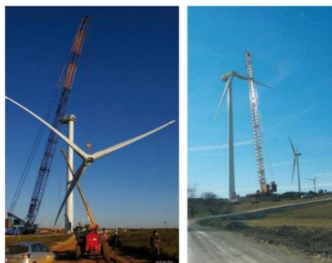
Photo 11 : Montage du rotor (à gauche), montage « pale par pale » (à droite)
