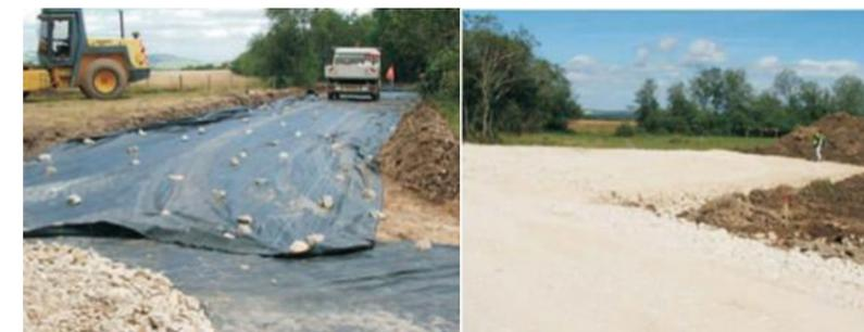
Photo 10 : Pose d'un géotextile (à gauche), état final d'une plate-forme (à droite)
