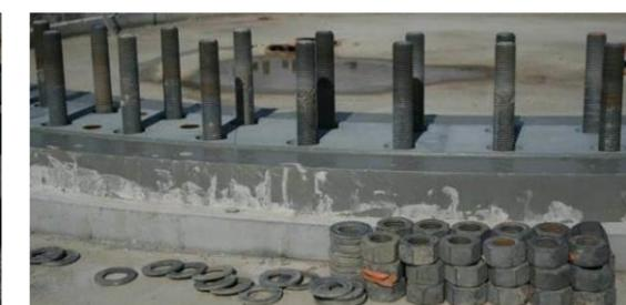
Photo 3 : Détail des fixations de la fondation
