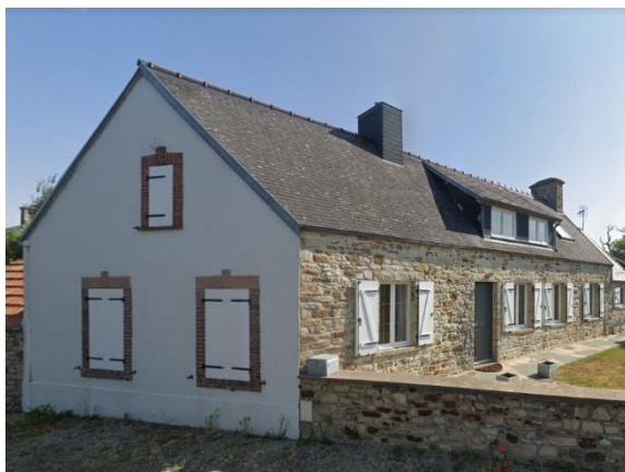
Exemple de logement ancien dans le bourg de la commune (secteur UB)
