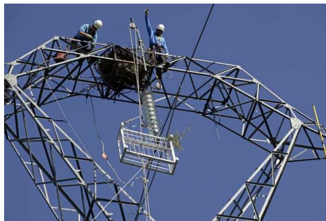
Figure 19 : Sécurisation d'un nid sur pylône par l'installation d'une nacelle. Source : Jean-François Lesigne - RTE – www.objectifbalbuzard.com
