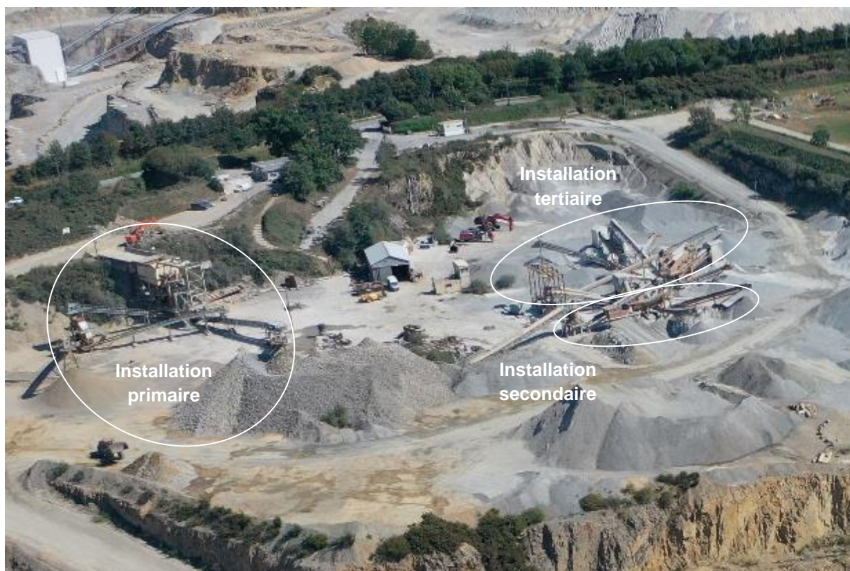
Figure 8 : Installation de traitement actuelle, vue depuis l'ouest (22/07/2021)
