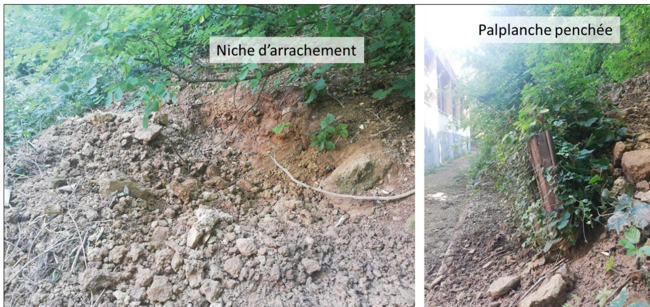
*Illustration 17 : Photographies des indices de déstabilisation : niche d'arrachement (à gauche) et palplanche penchée (à droite)*
