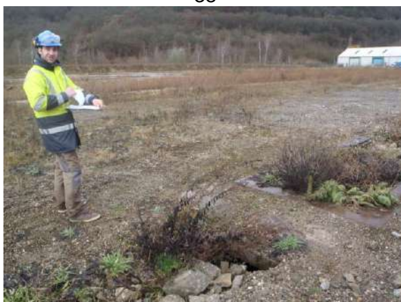
Sud du site, au centre de la zone des petits laminoirs, photo prise vers le nord. Vue sur une ancienne voie ferrée basse d'axe nord-sud, elle est en partie rebouchée.
