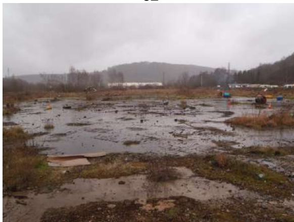
centre du site, au centre de la zone de la chaudronnerie. Vue générale sur une dalle béton avec plusieurs DIB.
