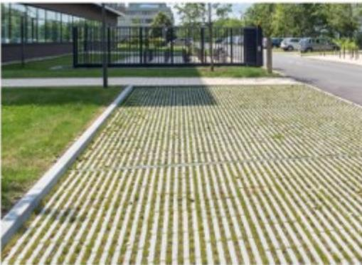
> Surfaces perméables sous stationnement
