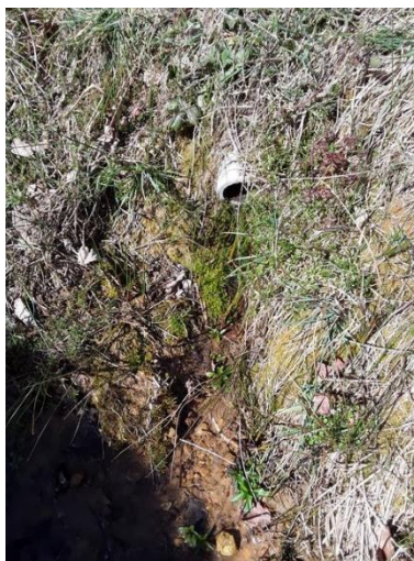
17 – Vue d'un drain au niveau d'une zone humide caractérisée par le sol (S11)
