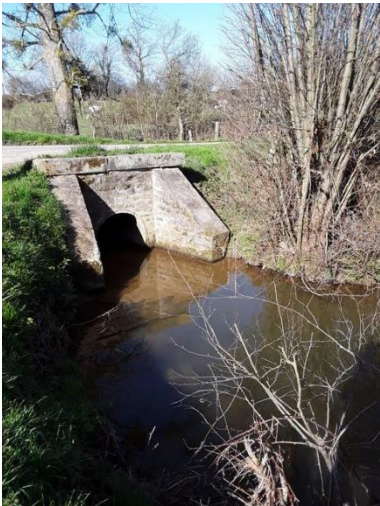
4 – Ouvrage Route avec fosse en aval (S3)
