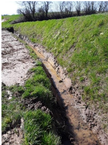
14 – Curage des fossés de bord du chemin (évacuation dans affluent)
