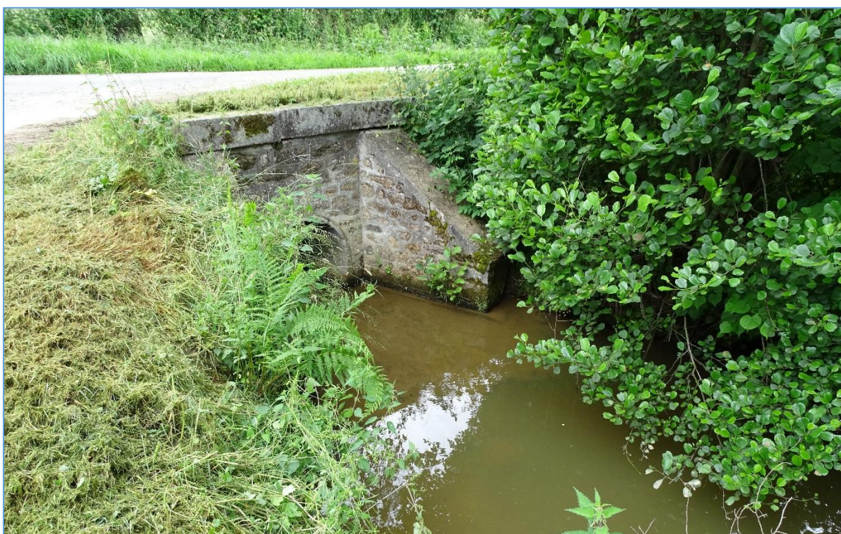
Fig. 4 : Vue n°2 : Ruisseau du Pont de l'Épine en aval du site (juin 2021)
