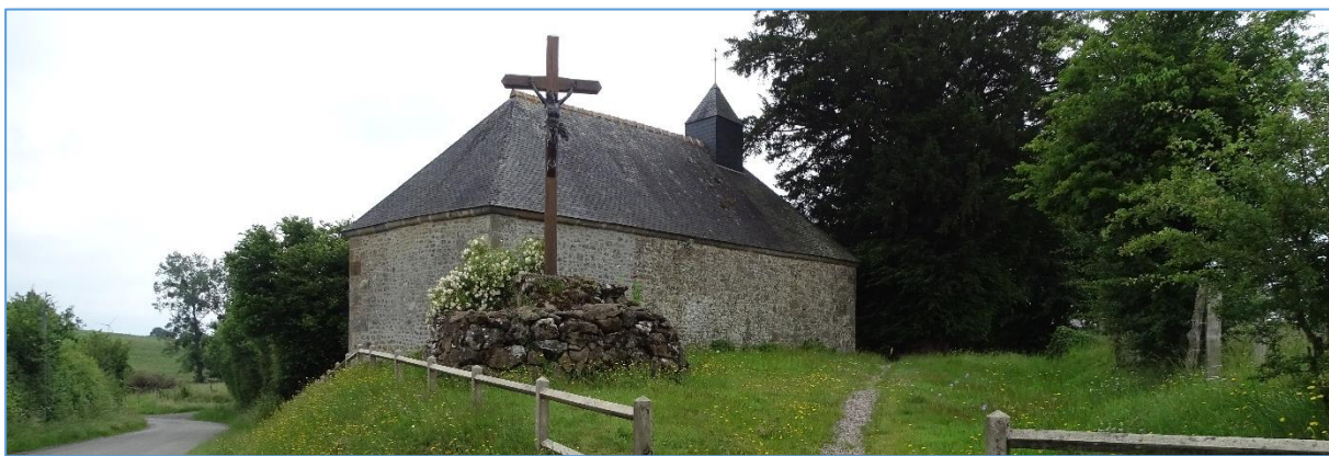
Fig. 13 : Vue F sur la chapelle à proximité du projet
