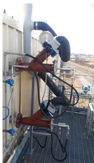
Injection Ammoniaque / air comprimé dans le réacteur
