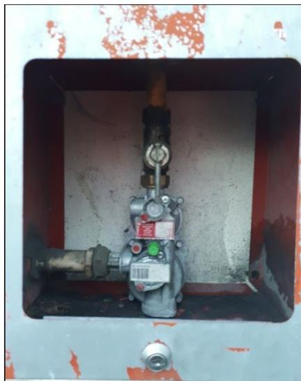
Vanne de coupure et détendeur dans une logette non étanche.
