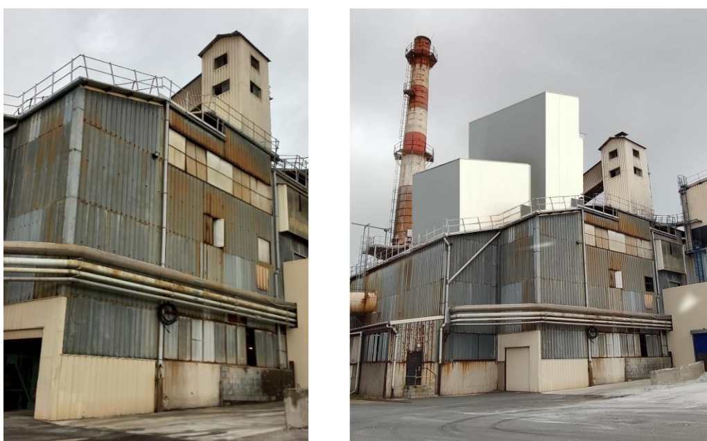
Figure 68 Situation actuelle et projetée du bâtiment accueillant le four 4 (source : permis de construire lié au rehaussement de toiture)
