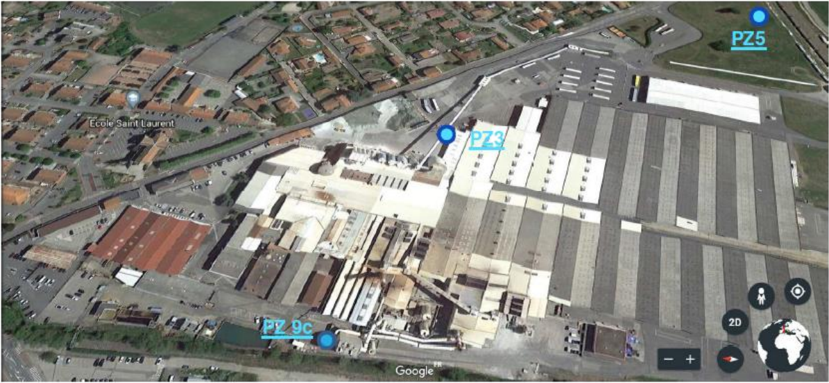
Figure 14 Localisation des piézomètres faisant l'objet de prélèvement lors des campagnes semestrielles (source : rapports de mesure – Bureau Veritas – Avril et octobre 2023)
