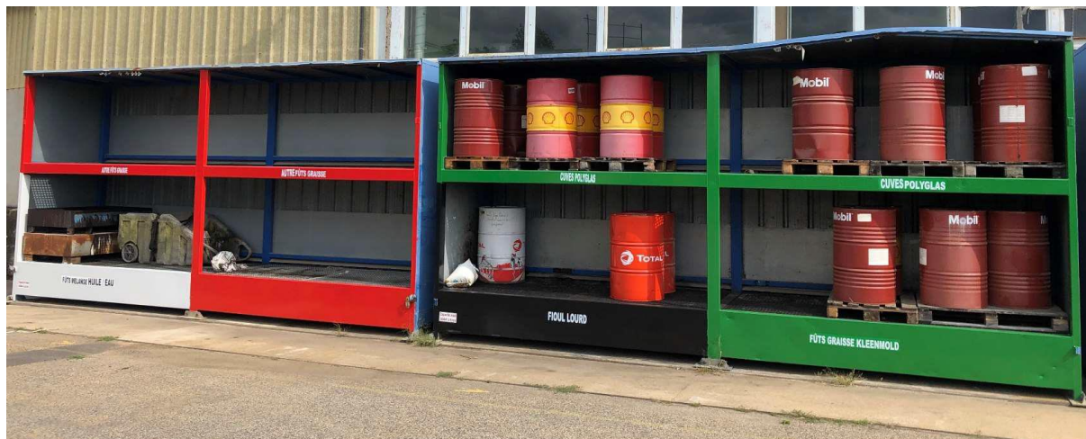
Figure 85 Zone de stockage des déchets dangereux
