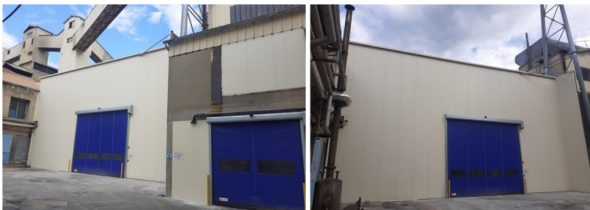
Figure 80 Ecran acoustique mis en place devant le four 4 – machine 43 - façade Ouest
