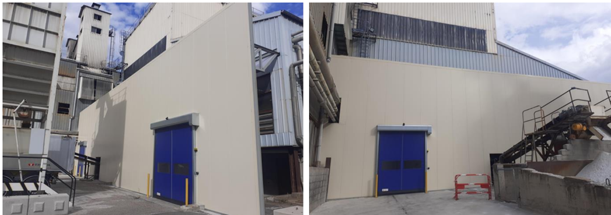
Figure 79 Ecran acoustique mis en place devant le four 4 – machine 40 - façade Ouest
