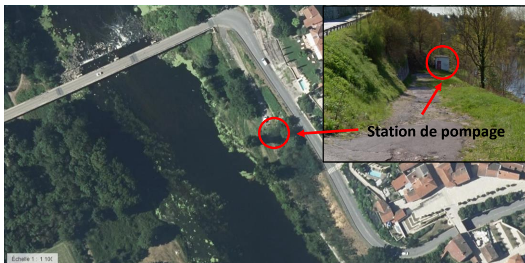
Figure 23 Vue aérienne de la localisation de la station de pompage (Source : Géoportail)
