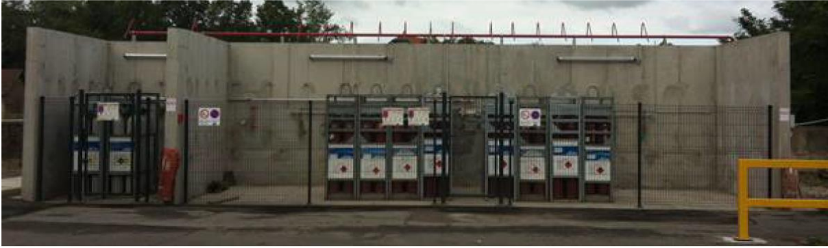
Figure 38 Photo de la zone de stockage d'acétylène
