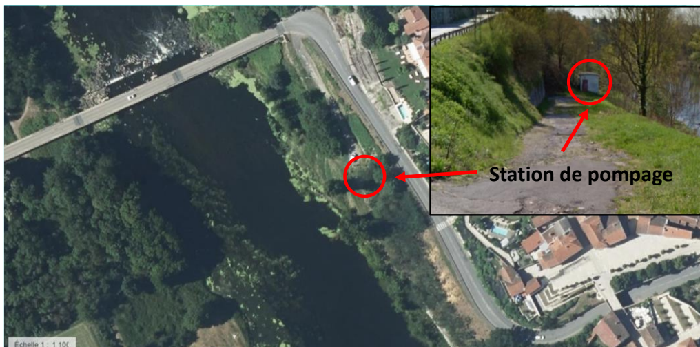
Figure 64 Vue aérienne de la localisation de la station de pompage (Source : Géoportail)
