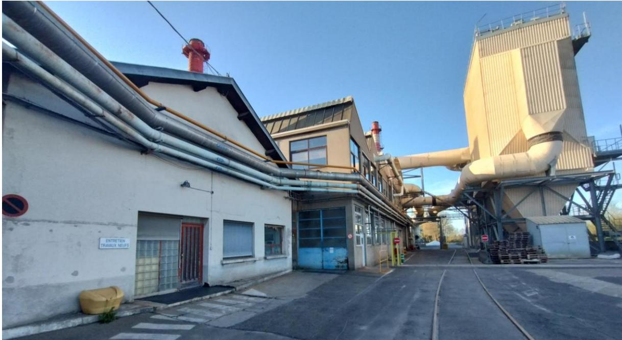
Figure 9 - Nouvelle canalisation aérienne alimentant le DéNOx et le F4
