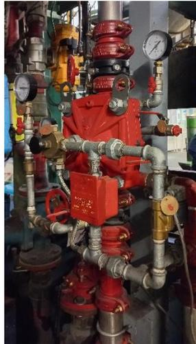
Figure 7 Equipement lié au système de déluge
