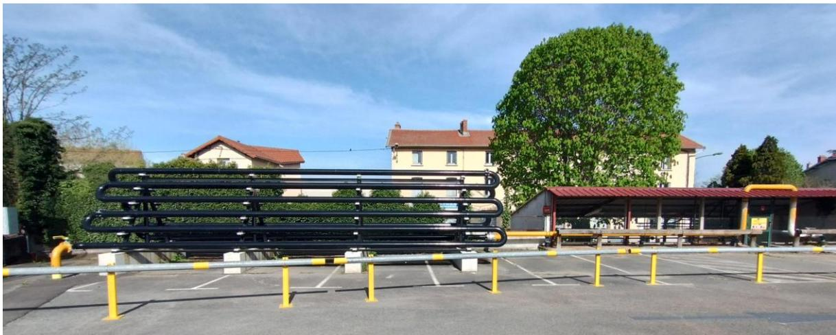
Figure 8 - Piquage de la nouvelle canalisation et du réchauffeur sur le poste GRTgaz
