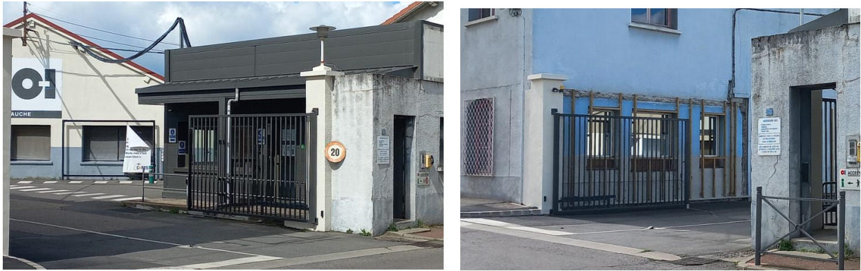
Figure 3 Accès principal depuis la rue Abbé Delorme
