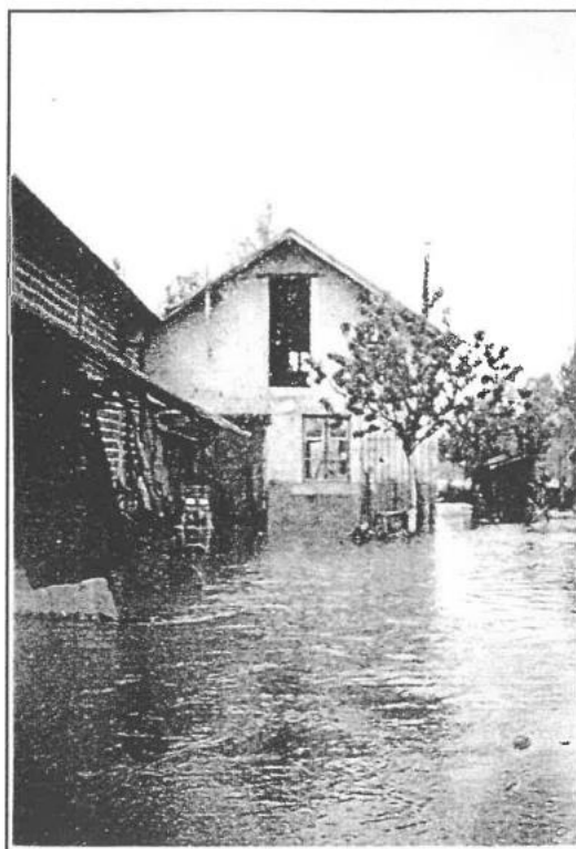
Photo 5 : VALLON-en-SULLY - 1940 - Hangar rue du CHER.
