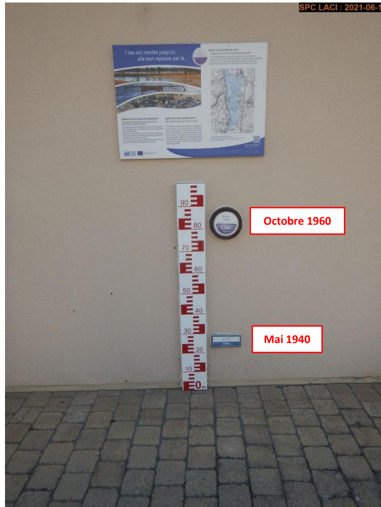
Figure 6 : Exemple de laisses de crue recensées sur la commune de Vaux (source : https://www.reperesdecruces.developpement-durable.gouv.fr/ )
