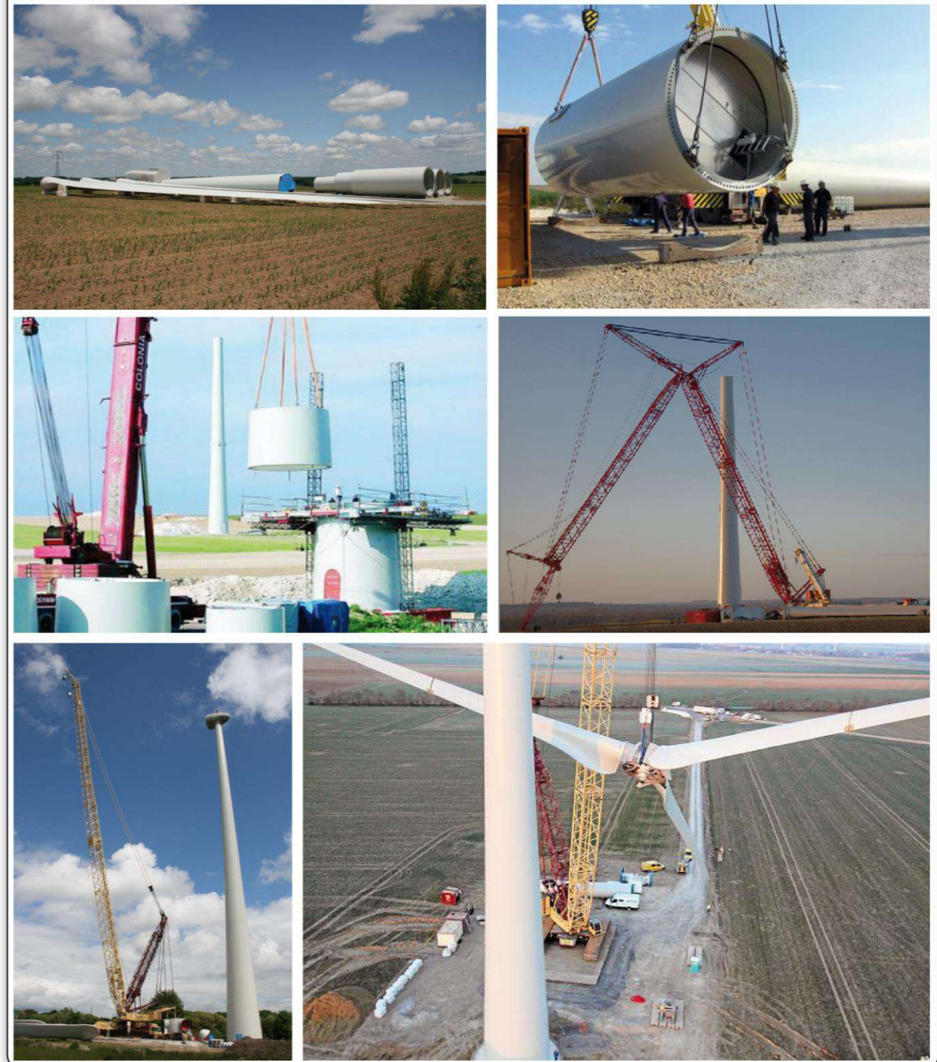
Montage d'une éolienne
