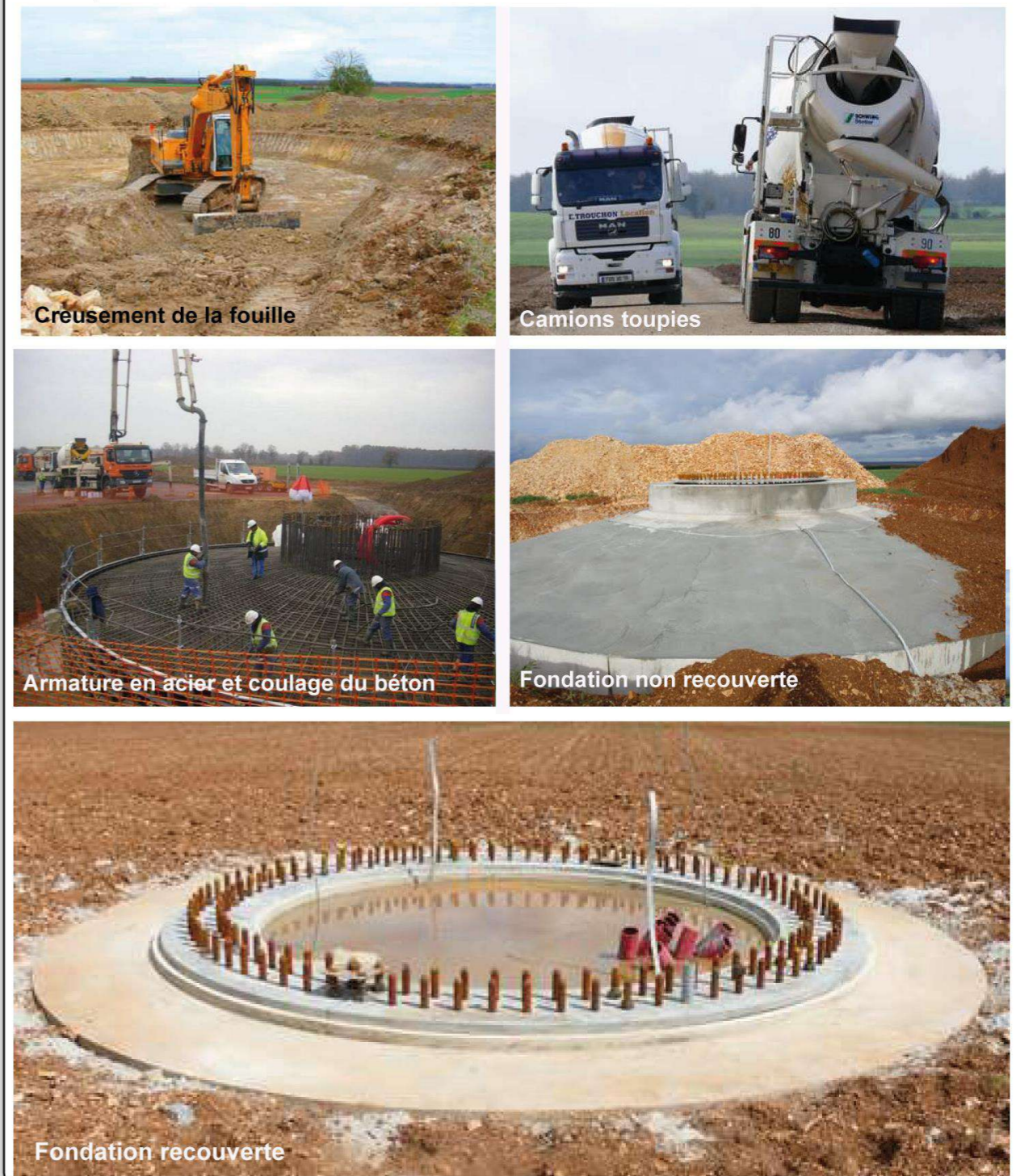
Photographie 38 : Étapes de réalisation d'une fondation d'éolienne
