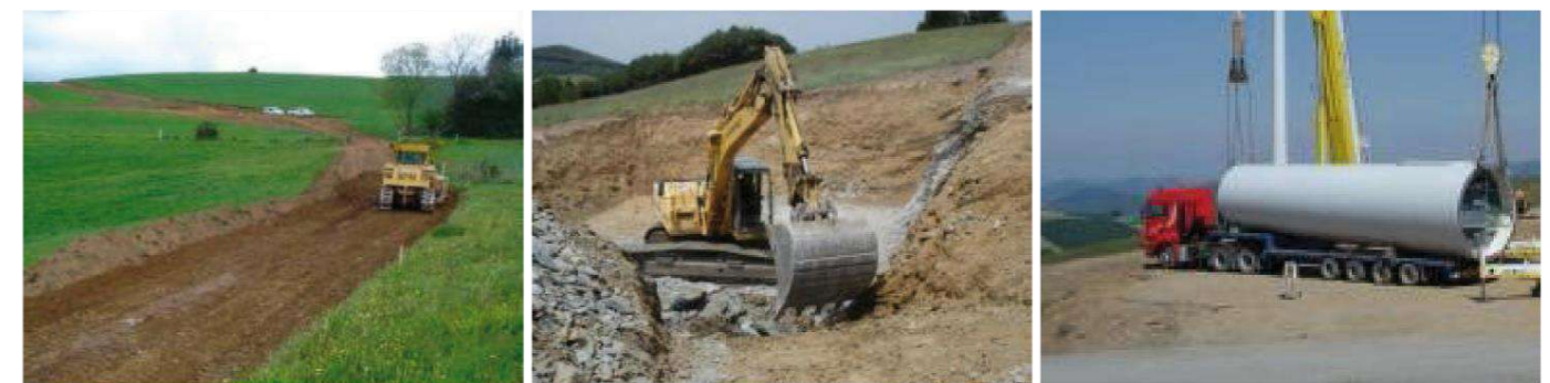
Photographie 44 : Illustration d'un chantier éolien
