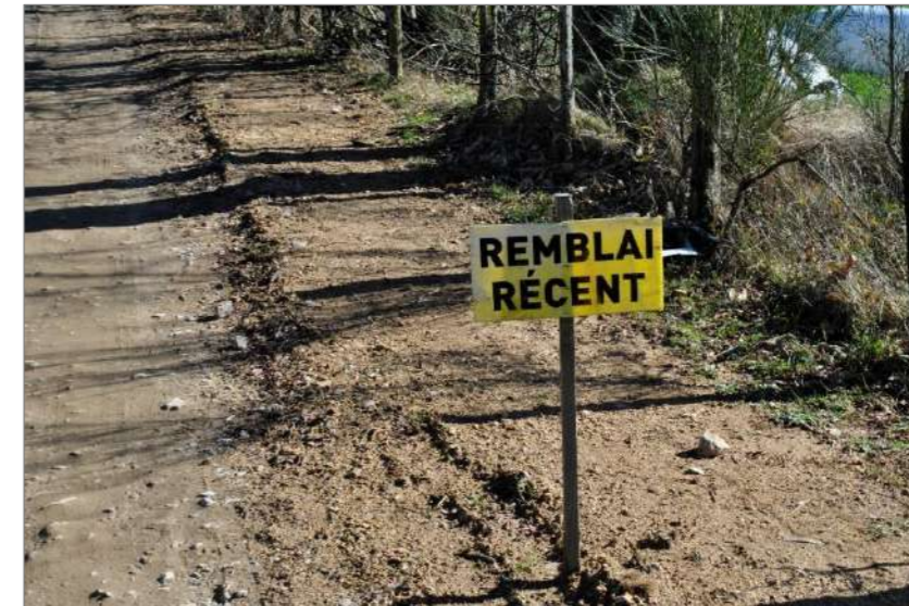
Photographie 41 : Exemple de remblai des tranchées électriques le long d'une piste (Source : ENCIS Environnement)
