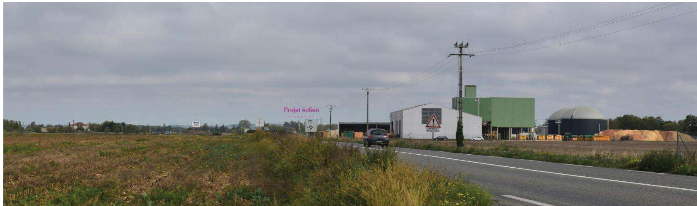
Photographie 49 : Vue sur le projet éolien depuis les abords du camp de concentration et d'internement du Vernet, au bord de la D820 (photomontage n°1)
