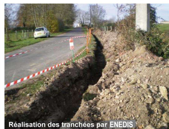
Photographie 39 : Travaux de raccordement électrique
