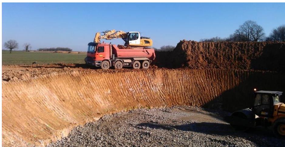
Illustration 54 : Travaux pour une fondation Source : ABO WIND
