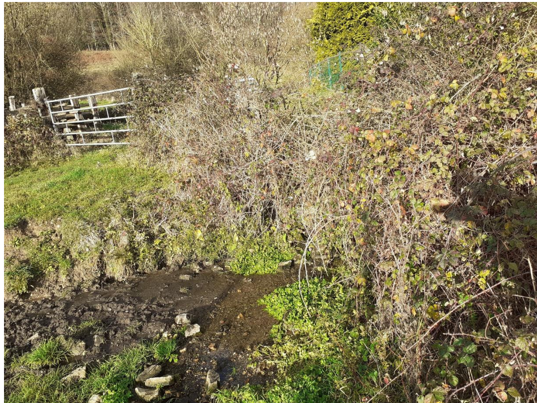
Figure 2-9 : Vue sur le début du ruisseau de la Roulandière (CPGF-HORIZON, photographie de la visite du 15 décembre 2020)
