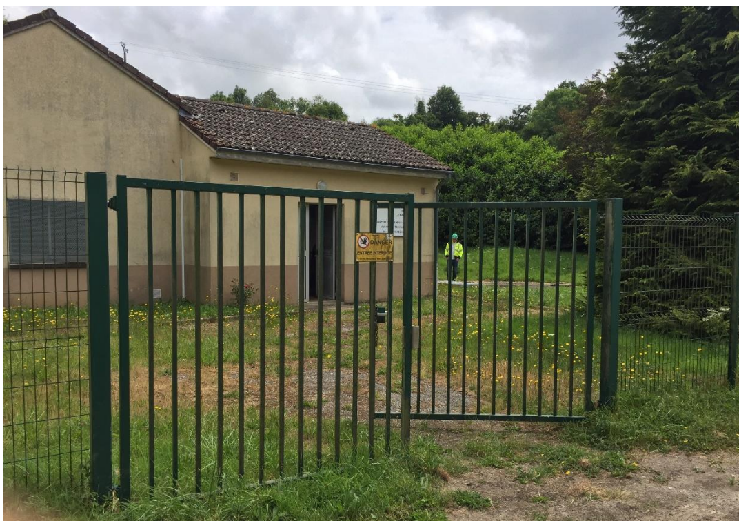
Figure 2-4 : Vue sur la station de pompage et de traitement et sur le portail d'accès (CPGF-HORIZON, photographie de la visite du 15 décembre 2020)
