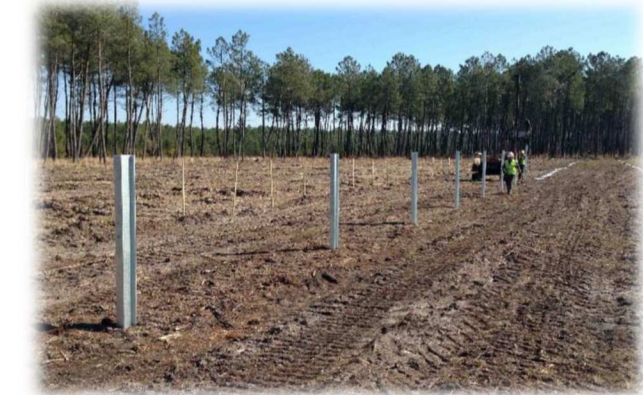
Ancrage au sol par pieux battus
