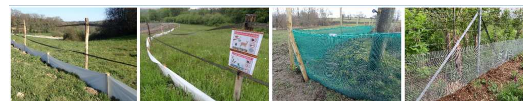
Exemple de clôture anti-pénétration en phase travaux (Source Crexeco)
