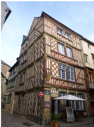
Fig. 4 et 5 : 22 rue du Chapitre
