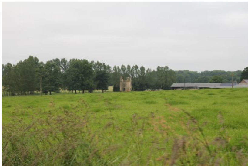
Hangar inséré dans la pente – vallée de la Flume
