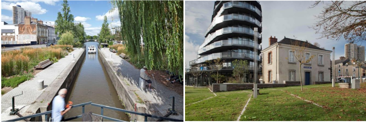
Fig. 1 : L'écluse du Mail, 1826 et sa maison éclusière, 1865. © Inventaire général, ADAGP
