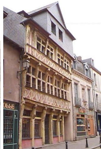
Fig. 6 : 32 rue de Saint-Malo
