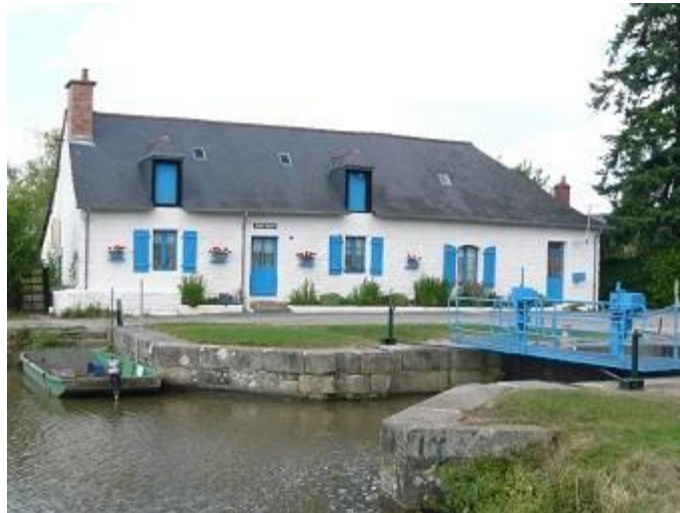
Bruz, maison éclusière à Pont-Réan. © Gaëlle Rageot, SRI.
