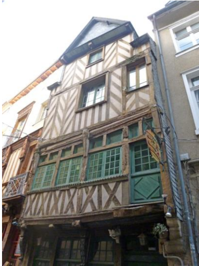
Fig. 1 et 2 : 18 rue du Chapitre
