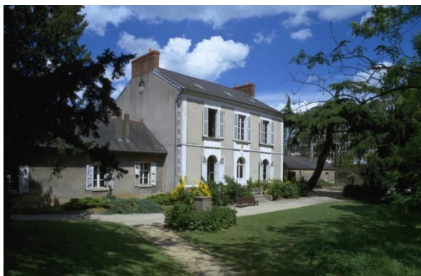
Fig. 1 Ancien logement patronal, Jardin Jean Guy, Rennes
