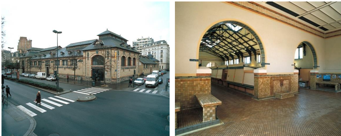
Fig. 5 et 6 : Halle centrale, vue générale et vue des étals de poissonnerie depuis le pavillon sud-est © Inventaire général, ADAGP
