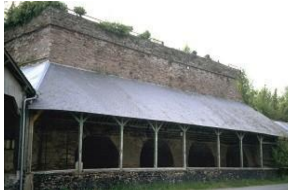
Chartres-de-Bretagne, les fours à chaux. © Marina Gasnier, SRI.
