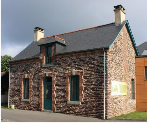
Fig. 1 : Maison longue, ancien logement des instituteurs, Laillé © Région Bretagne
