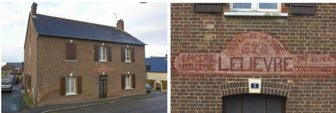
Fig. 3 et 4 : Hôtel de voyageurs dit pension Lelièvre, vue générale et détails des inscriptions sur la façade principale © Région Bretagne
