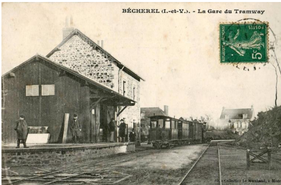
Bécherel fut desservie par une ligne secondaire qui la reliait à Rennes de 1902 à 1947
