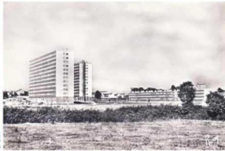
© D.R. Construction des Cloteaux, quartiers sud de Rennes.
