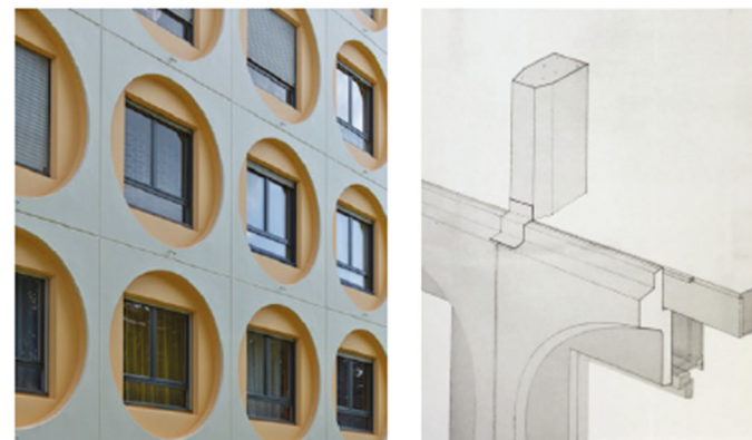
Principe des panneaux originels préfabriqués (dessin G. Maillols).
