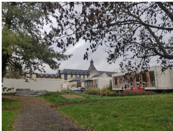
Façade arrière du bâtiment, vue depuis le sud-ouest photo © DLEL
