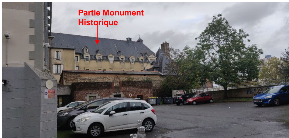
Façade sud du bâtiment, vue depuis l'intérieur du parc © DLEL
