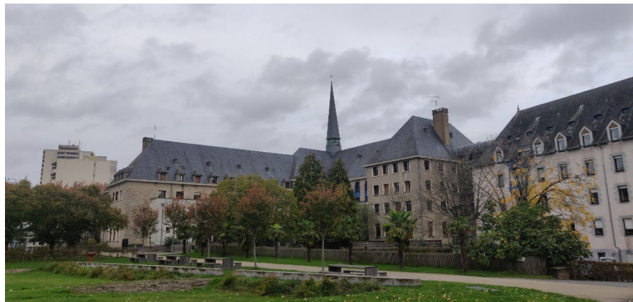
Vue depuis l'intérieur du parc sur la partie du bâtiment non MH © DLEL
