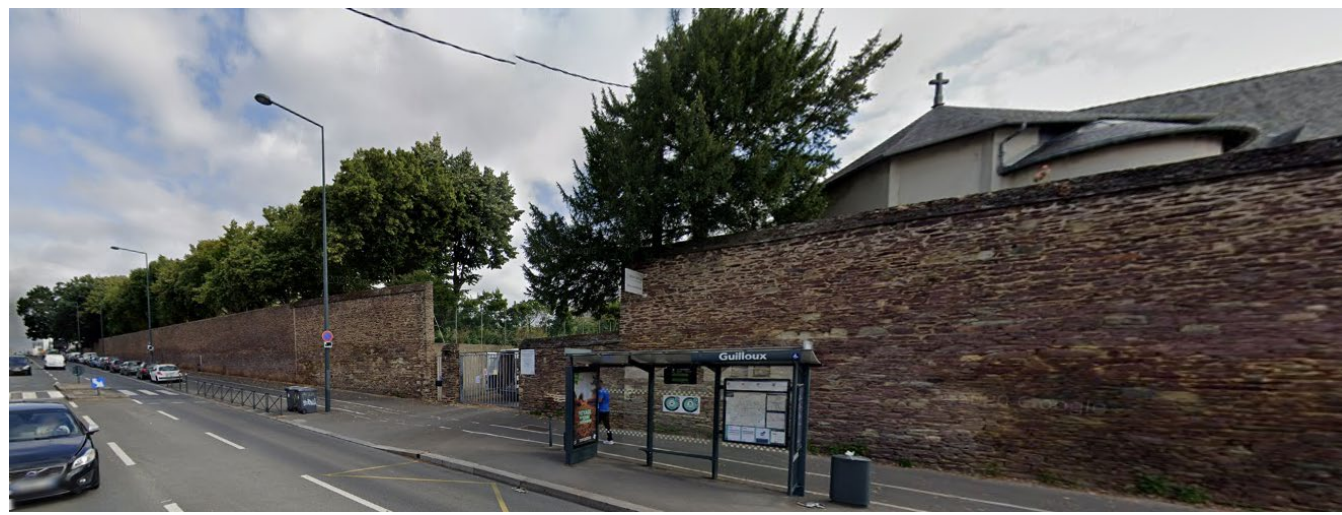
Mur d'enceinte vu depuis la rue Louis Guilloux (© google maps)
