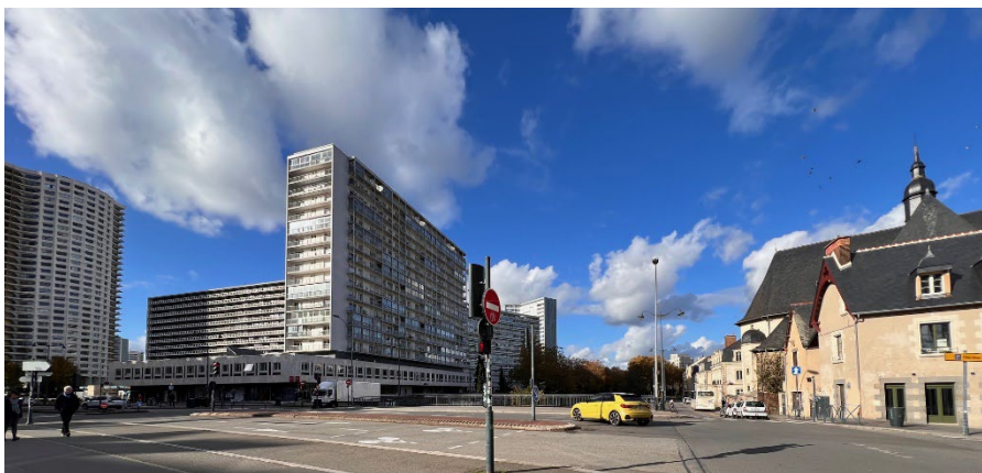
Les immeubles émergents du quartier Bourg L'Evesque (les Horizons et le Penthium) en covisibilité avec certains MH
