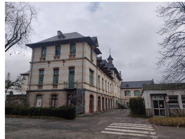
Vue sur le pignon ouest du Monument Historique photo © DLEL
