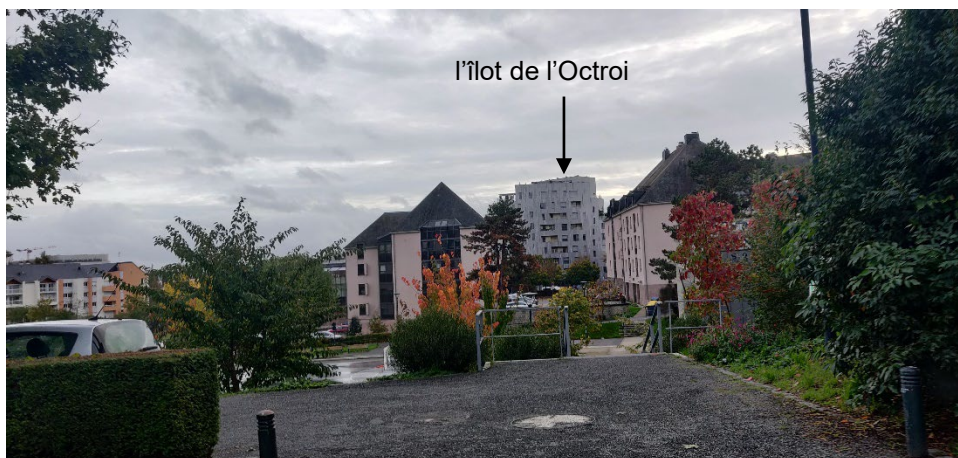
Vue depuis l'intérieur du parc vers le sud, au-delà de la rue Louis Guilloux
