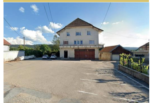
accès à l'arrière de la parcelle, depuis la AE 17 (streetview)
