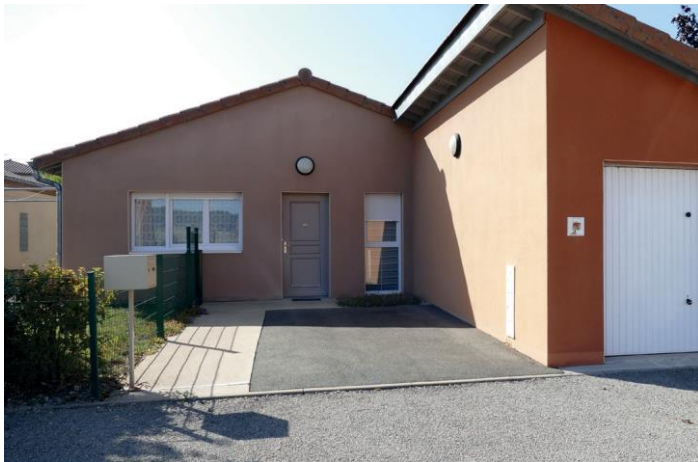
Maison individuelle _ Matour (71) 5 logements sociaux, 2012
