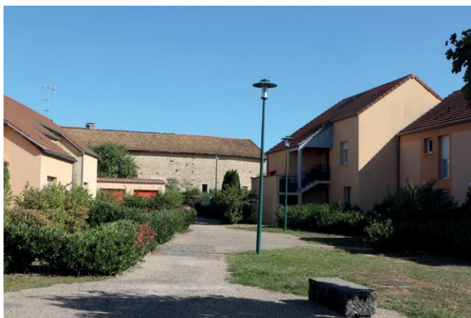
Habitat intermédiaire_ Sainte-Marie-la-Blanche (21) 24 logements, 2007 - 2015
