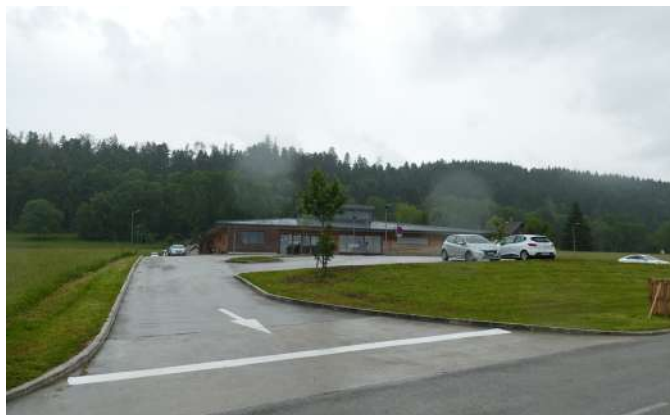
L'école est ici implantée à la marge du centre-bourg de Sombacour.
