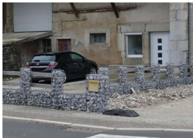
Exemple d'un muret bas en gabions - Évillers
