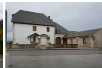
Presbytère à Goux-les-Usiers
