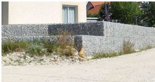
Exemple d'un mur de clôture haut en gabions - Le Souillot (Chapelle-d'Huin)
