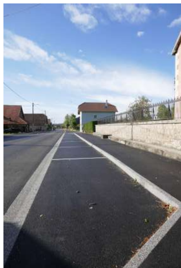
Aménagements réalisés à Evillers
