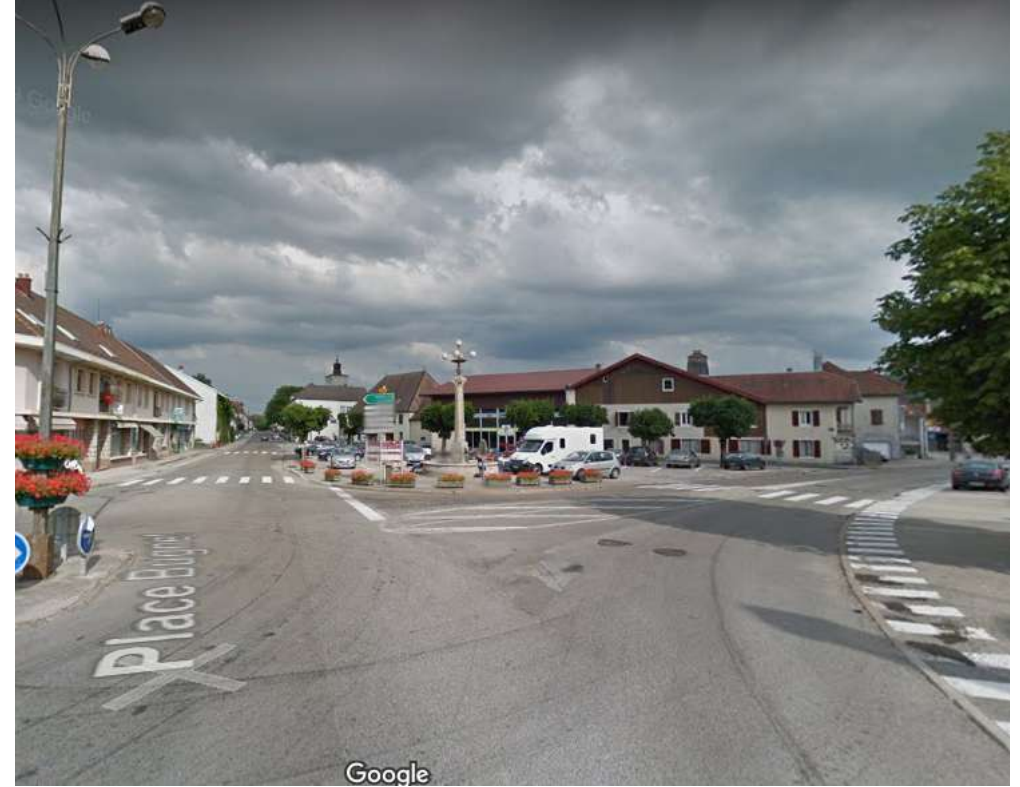
Place de Levier avant les travaux (source : streetview)
