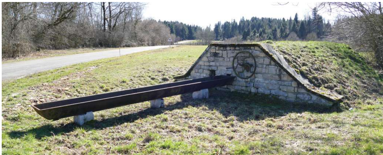
Source entre Villeneuve-d'Amont et Gevresin
