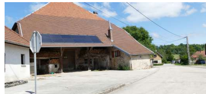
Ferme «pastorale à galerie»_Villers-sous-Chalamont
