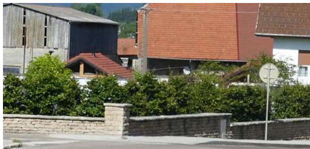
Muret bas en pierres sèches couronné entourant une ferme à Sombacour
