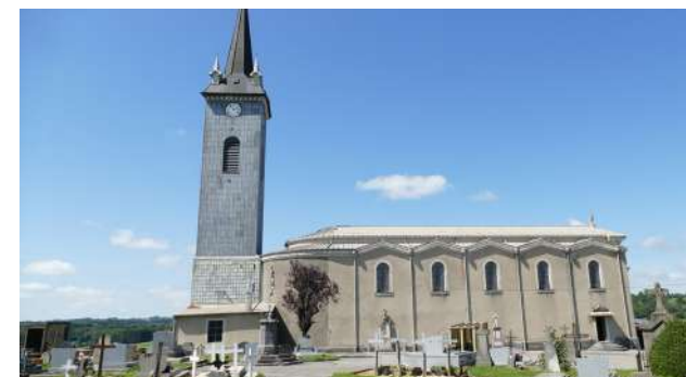
Église Saint-Laurent, Arc-sous-Montenot
