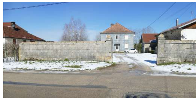
Mur d'enceinte haut du presbytère de Villeneuve-d'Amont
