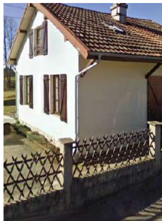
Clôture basse réalisée avec un soubassement béton et un grillage treillis bois - Villers-sous-Chalamont
