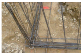
Nœud de chaînage - Continuité mécanique
