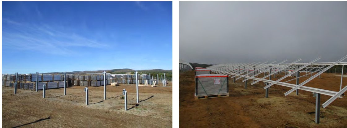
Figure 261 : Assemblage des structures sur site (source : Q ENERGY France)
