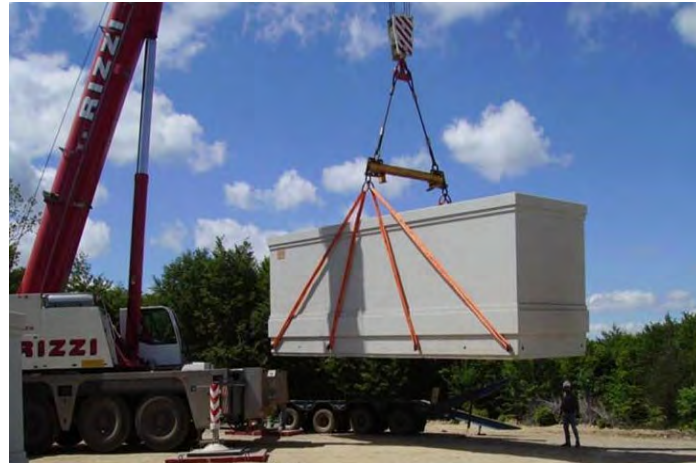
Figure 264 : Installation d'un poste électrique (source : Q ENERGY France)
