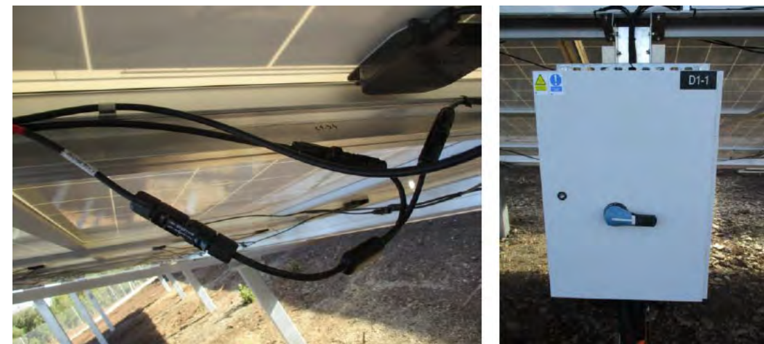
Figure 256 : Exemple de câble électrique et de boîte de raccordement (source : Q ENERGY France)
