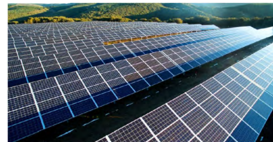
Figure 248 : Exemple de structure fixe (source : Q ENERGY France)
