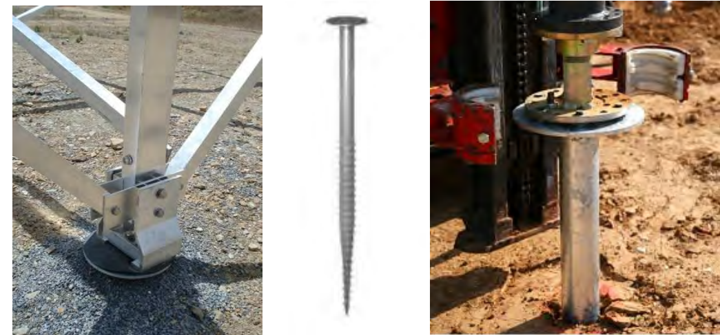
Figure 251 : Fondations à visser (source : Q ENERGY France)
