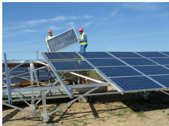
Figure 262 : Exemple de mise en place des panneaux sur les structures (source : Q ENERGY France)
