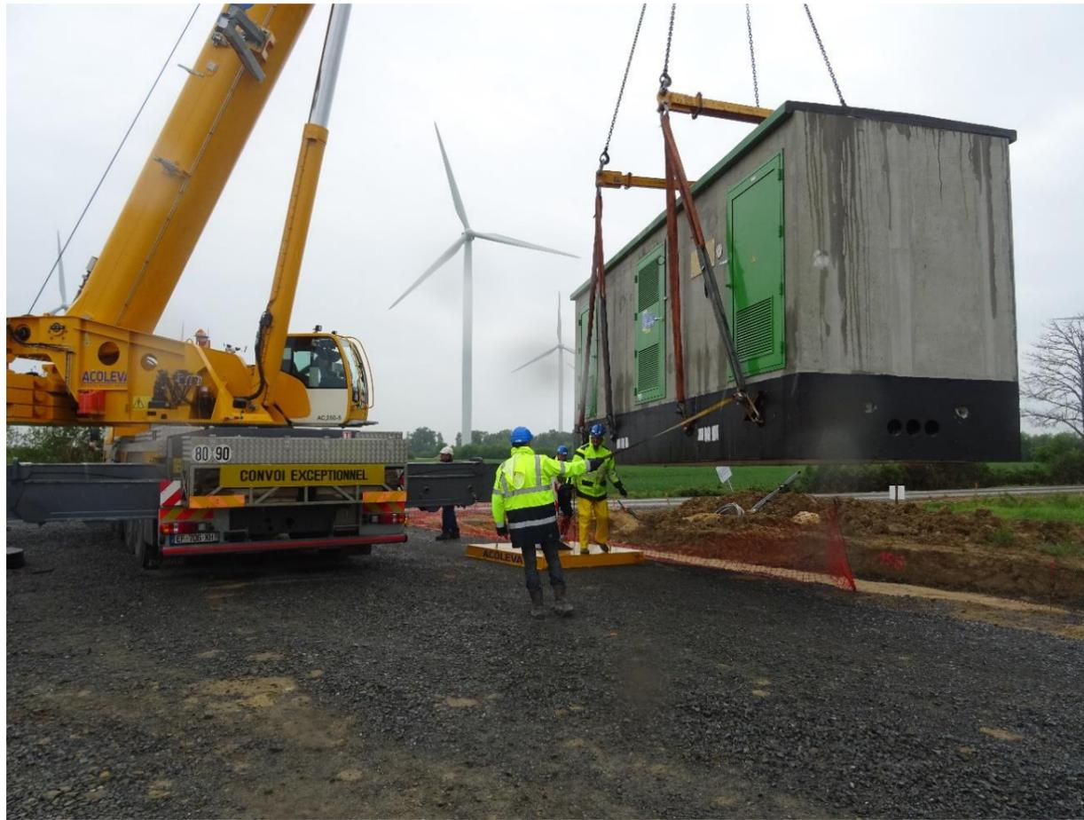
Le poste de livraison électrique d'Aulnay l'Aître sera situé sur la parcelle ZI 109, sur le lieu-dit « La Come », en bordure de la Route Départementale n°81. La structure du poste de livraison est réalisée en béton ou en parpaing. Le poste de livraison, d'une dimension de neuf mètres de long sur trois mètres de large, sera mis en œuvre en usine et livré en une pièce jusqu'au site, pour être déposé à l'emplacement prévu.
