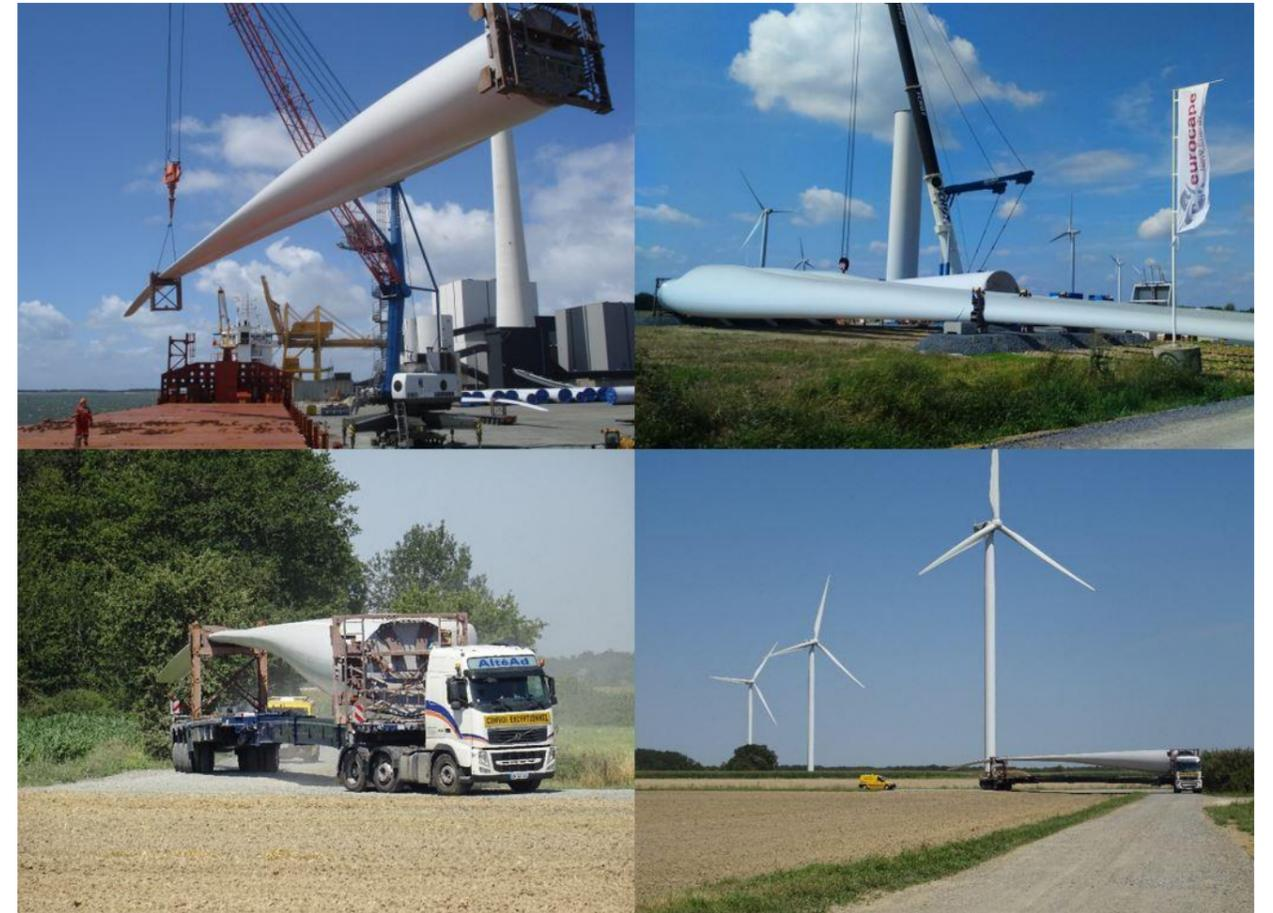
Les camions transportant les pales et la nacelle empruntent les pistes de construction, créées ou aménagées par le porteur de projet, pour déposer leur chargement avec l'aide d'une grue. Ils empruntent les mêmes chemins pour ressortir en marche arrière ; cette manœuvre est possible grâce aux remorques « rétractables » utilisées pour le transport de ce type de chargement.
