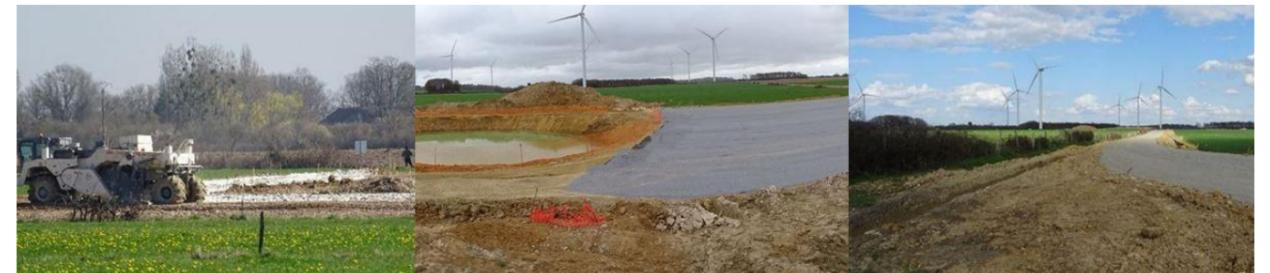
Les pistes seront stabilisées sur 5 mètres de large de manière à supporter le passage des engins pour la construction. La structure des pistes sera composée de plusieurs couches :
