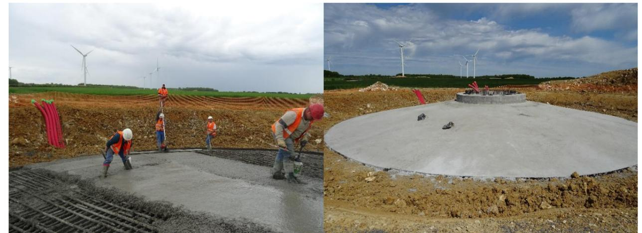
Le versement du béton permet d'obtenir la forme attendue grâce à la pose préalable d'une virole d'ancrage. C'est cette structure qui va donc assurer le bon écoulement du béton, qui est acheminé en continu sur le site. Un temps de séchage de plusieurs semaines est nécessaire par la suite, afin d'obtenir les fondations finales du parc éolien, dont le diamètre de chaque fondation, pour le projet d'Aulnay l'Aître, sera de 20, 50 mètres.
