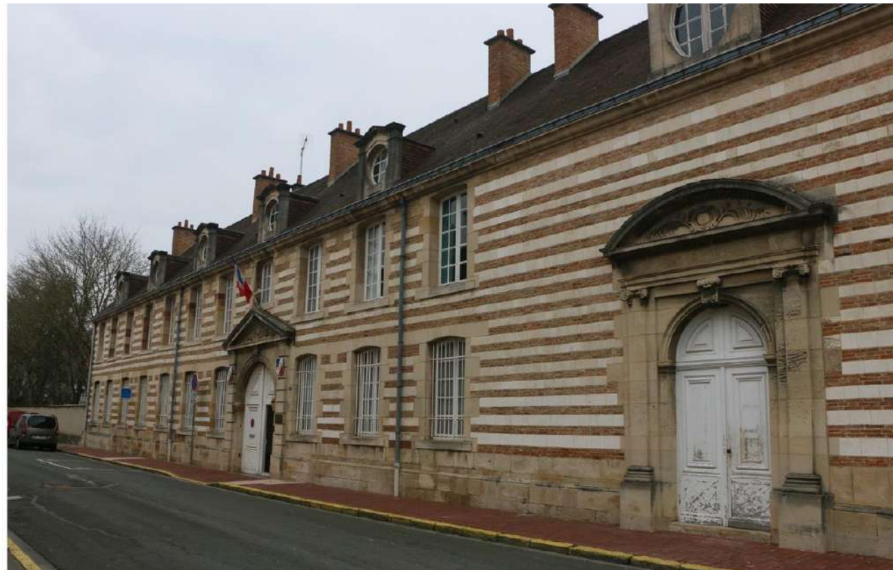
Figure 55 : Ancien hôpital de Vitry-le-François (source : ATER Environnement, 2020)
