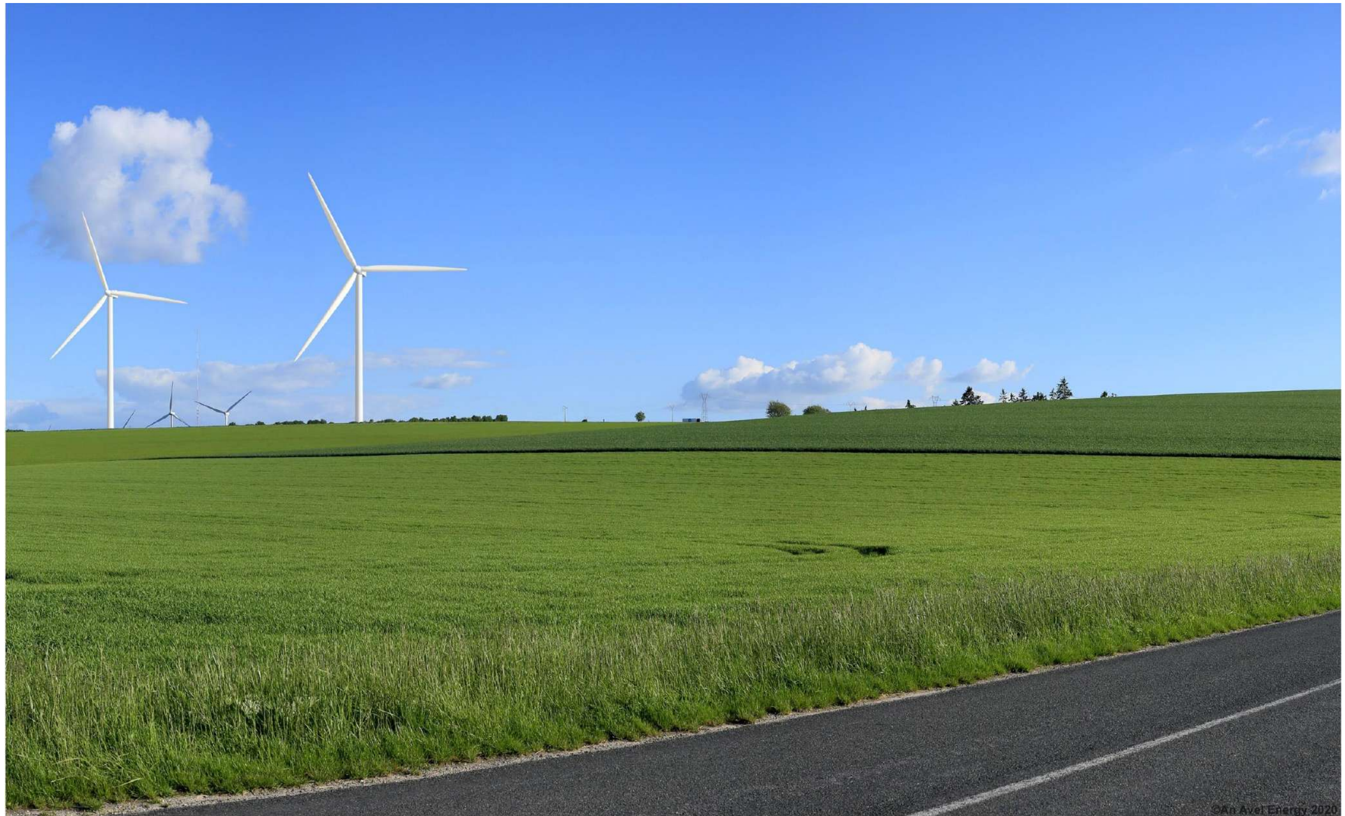
Figure 145 : Photomontage n°29 – Vue depuis la D81 en sortie sud-ouest d'Aulnay-l'Aître – Partie 4/4 (source : ATER Environnement, 2020)
