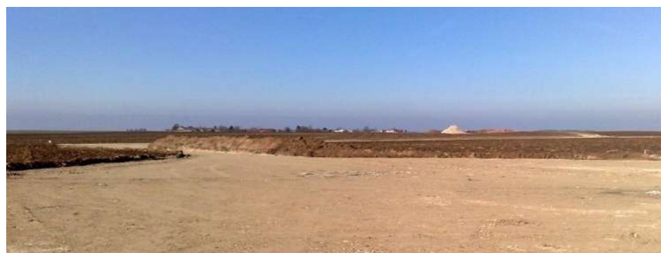
Figure 107 : Exemple d'aire de montage, grave compactée sur géotextile
