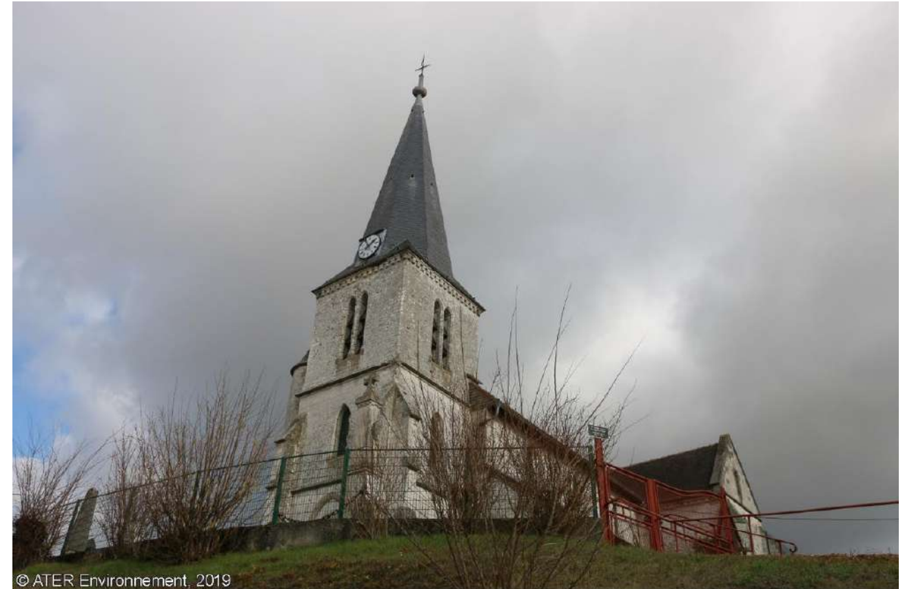
Figure 44 : Eglise de Châtelraould-Saint-Louvent (source : ATER Environnement, 2020)
