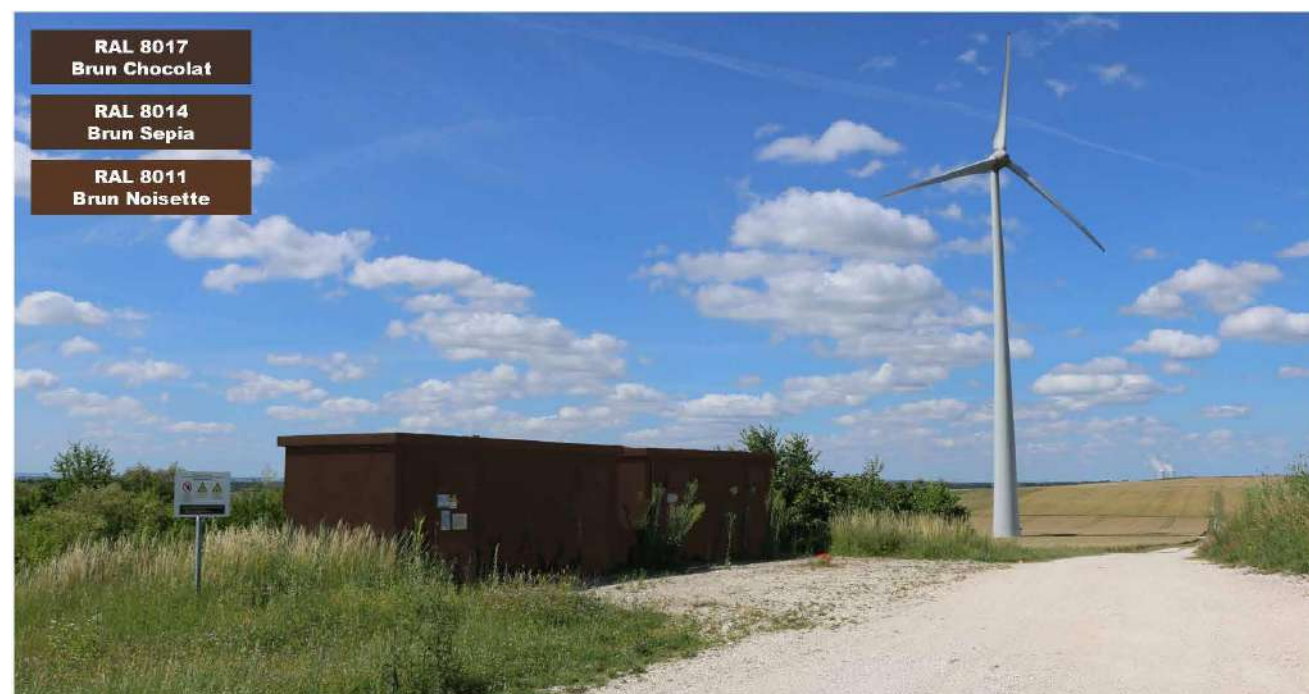
Figure 192 : Exemple de poste de livraison avec un habillage en enduit brun sombre (source : ATER Environnement, 2022)
