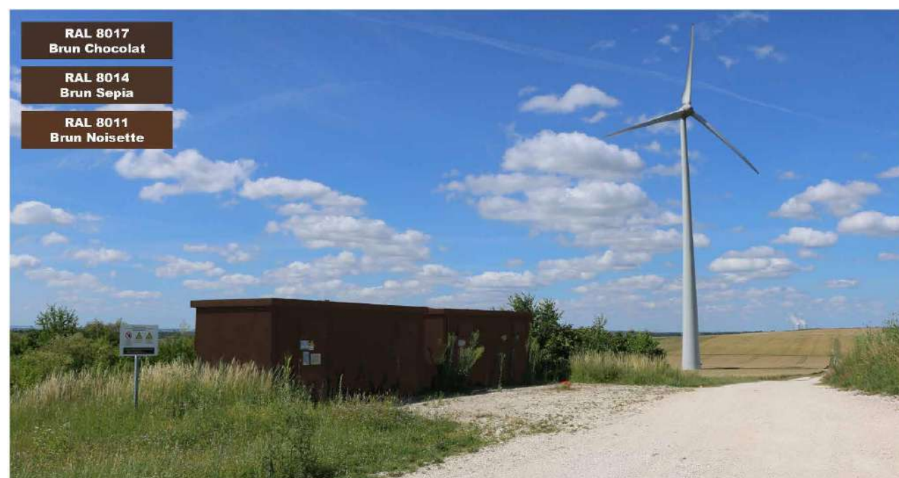
Figure 105 : Illustration d'un poste de livraison (source : ATER Environnement, 2022)
