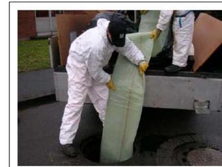
Figure 4.3 : Traction de la chemise
