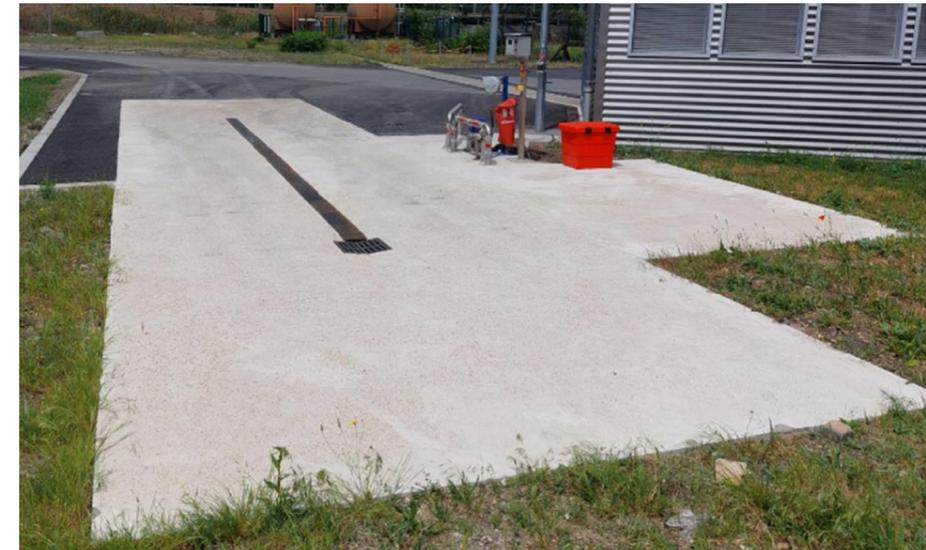
FIGURE 5 : EXEMPLE D'AIRE DE DEPOTAGE (SOURCE : DOSSIER PRO)
