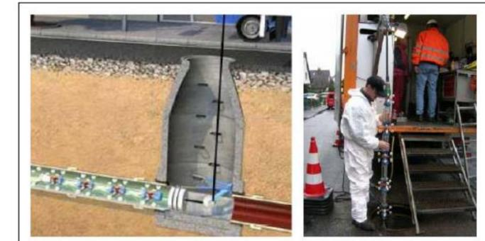
Figure 4.4 : Mise en œuvre du train de lampes
