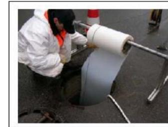
Figure 4.1 : Insertion du préliner
