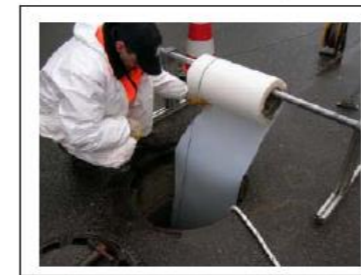
Figure 4.1 : Insertion du préliner
