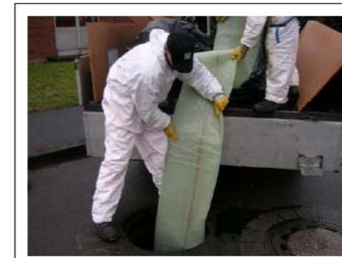
Figure 4.3 : Traction de la chemise
