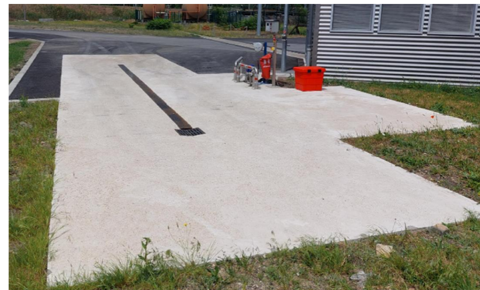
FIGURE 7 : EXEMPLE D'AIRE DE DEPOTAGE (SOURCE : DOSSIER PRO)
