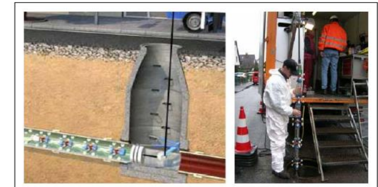
Figure 4.4 : Mise en œuvre du train de lampes
