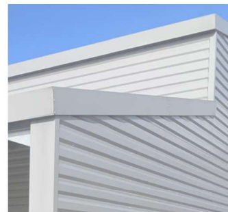
Bardage acier horizontal blanc RAL 9016
